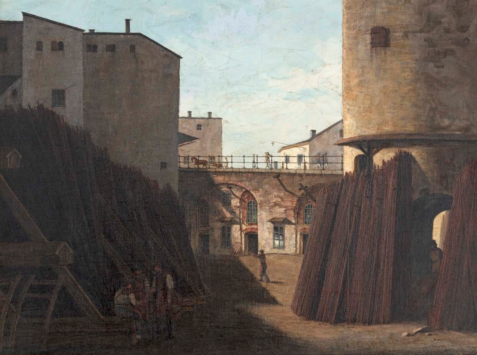
Figur 398. "Gamla Jernvägen vid Slussen". Målning av Johan Fredrik Julin (1798-1843). Lägga märke till Jämbäraren centralt i bild och allt stångjärn som står lutat mot byggnaderna inne i Järngraven. Bilden är beskuren. Stadsmuseet i Stockholm (CC BY).
