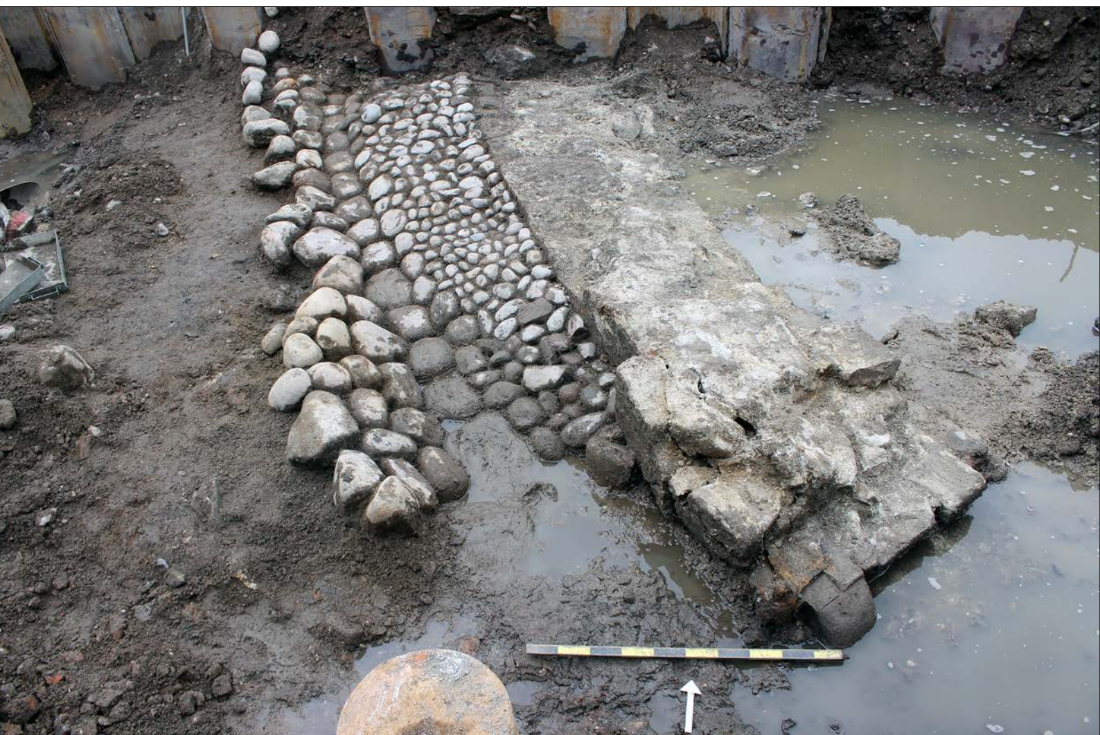
Figur 324. Rest av en stenläggning med rännal som var lagd dikt an emot södra sidan av skiljemuren (grupp 37). Skiljemuren åtskilde Järngraven från Stadsgården. Foto från söder.
