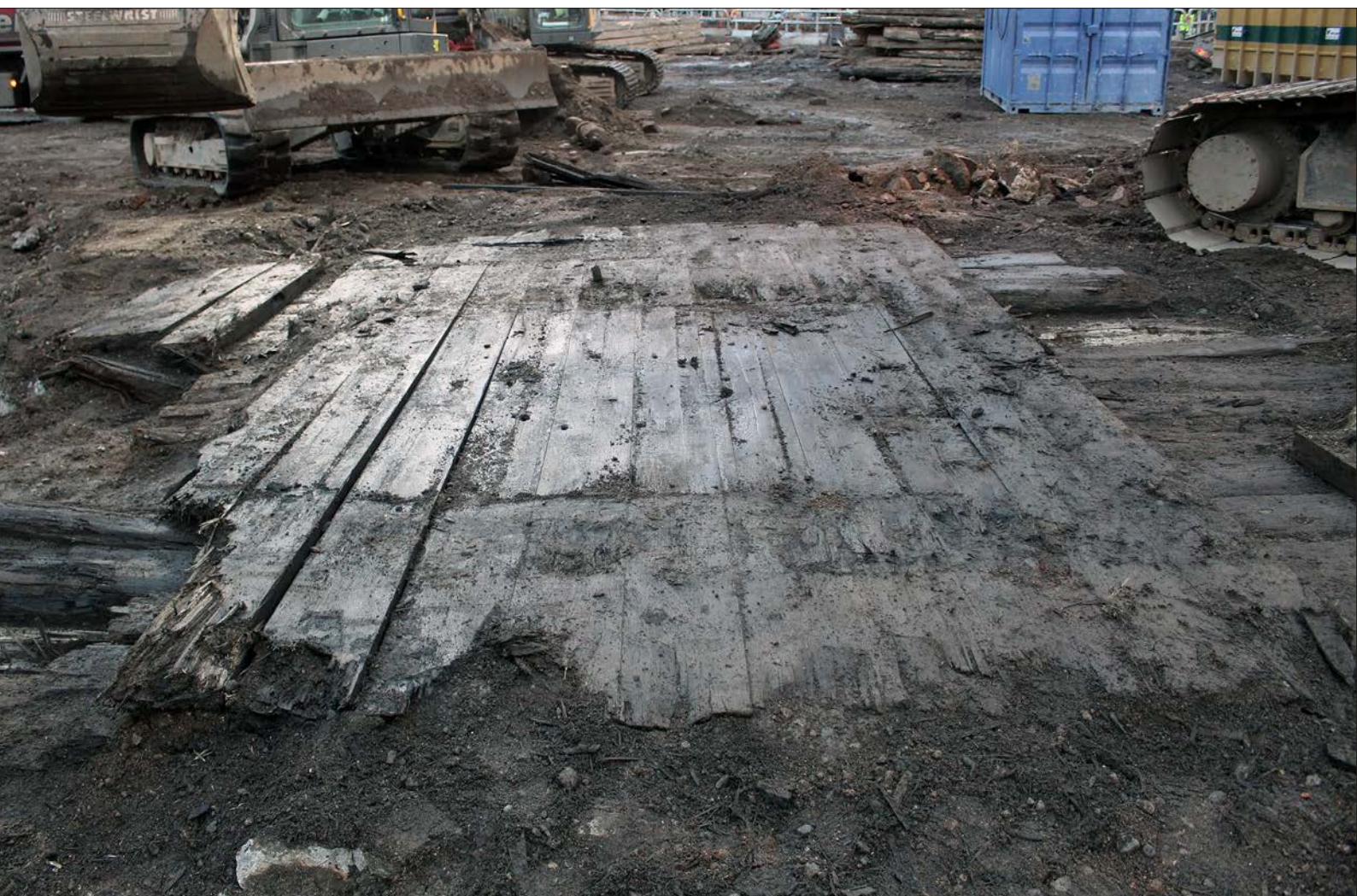
Figur 371. Rester av en rustbädd som hörde till stickspåret från järnvägens Södra stambana och som gick genom Järngraven under 1800-talets andra hälft. Foto från väster.
