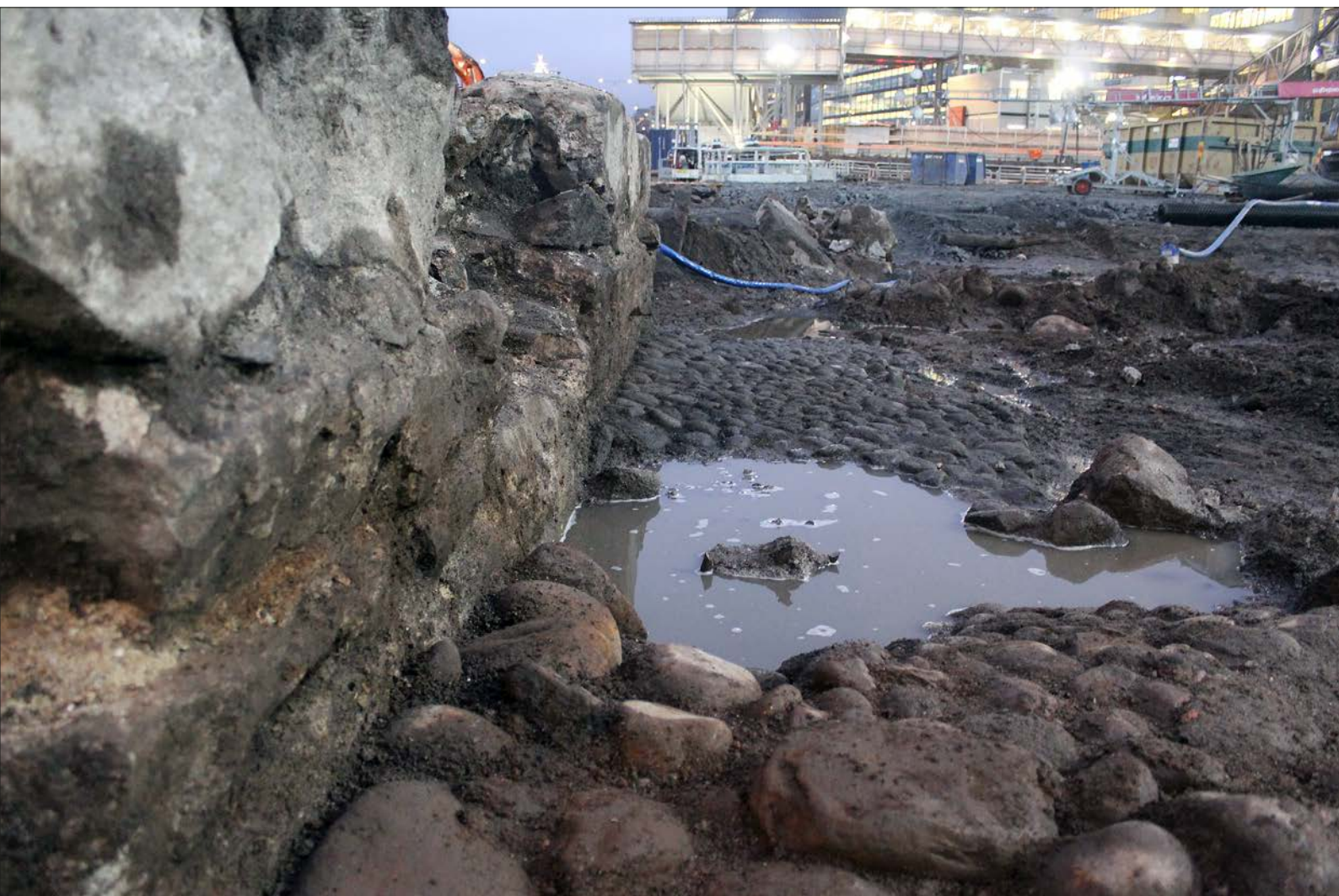
Figur 265. Kullerstensbeläggning 8137 mot grundmur 8011 i Östra Passagebron. Foto från nordväst.
