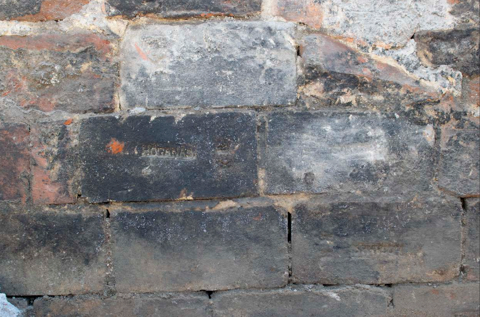
Figur 315. Närbild på teglet i spisväggarna. Lägg märke till stämpeln "HÖGANÄS" i teglet. Produktionen av eldfast tegel vid Höganäs startade först 1826.
