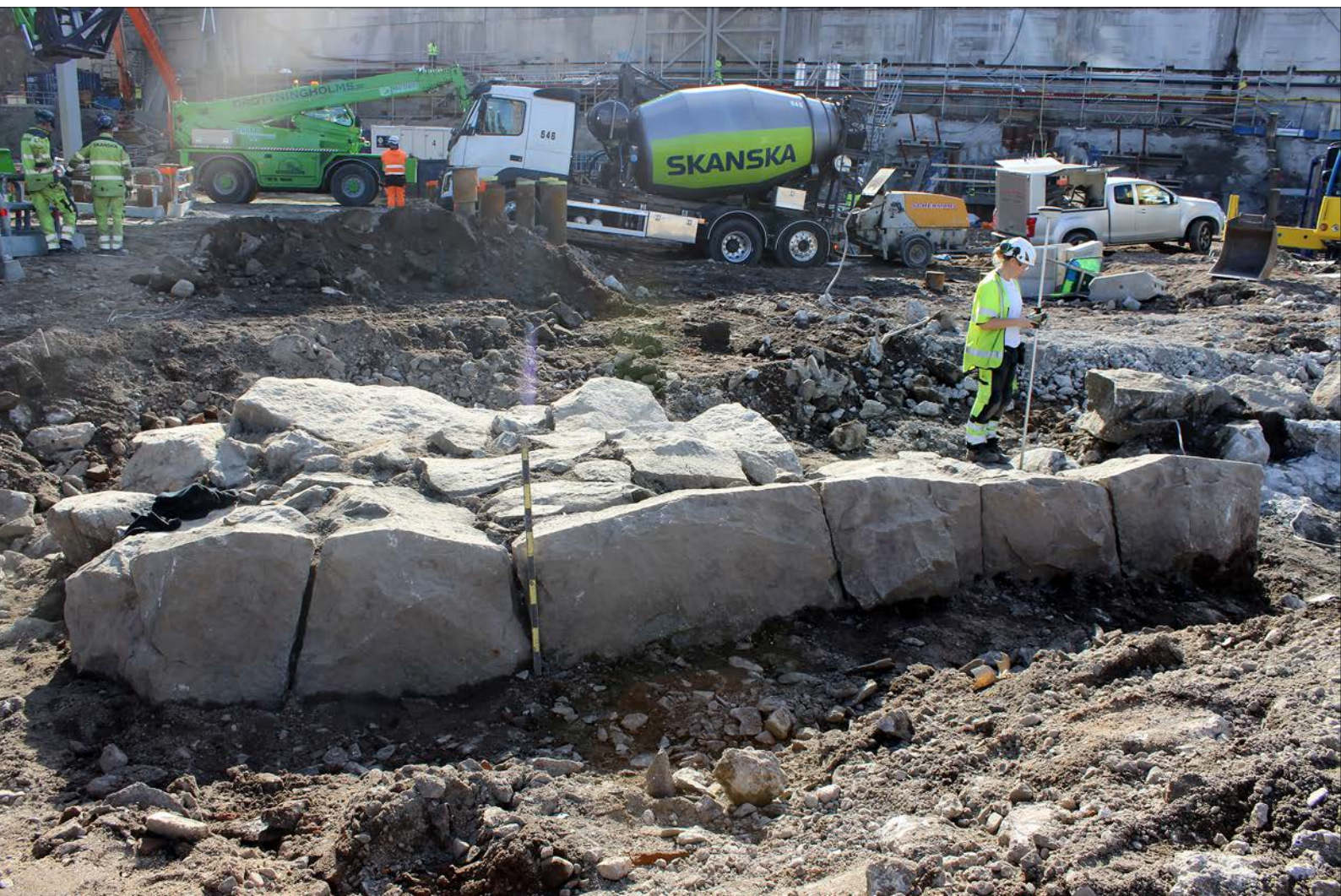
Figur 359. Del av uppkörningsrampen framrensad. Ursprungligen tillhörde grundmuren den östra begränsningen av Östra Slussgatan. Foto från nordöst
