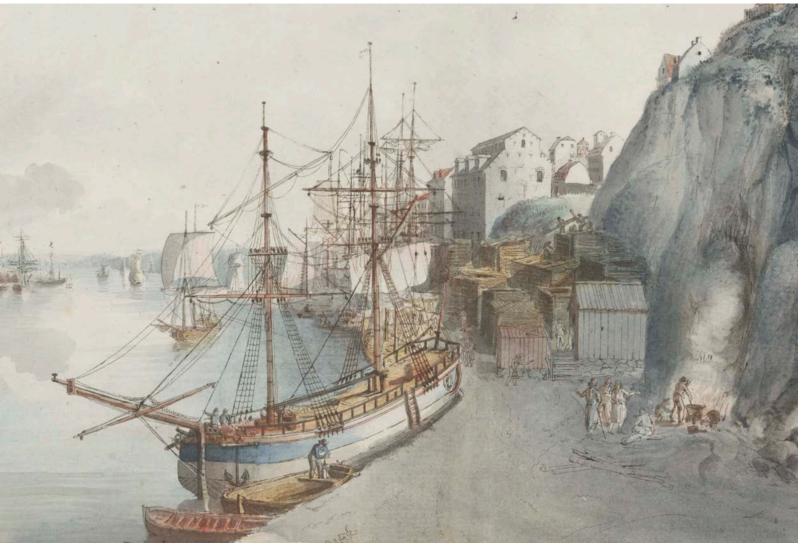
Figur 392. Detalj av en akvallererad konturetsning av Martin Rudolf Heland, 1790-tal, "En del af Stadsgården kallad Barlast-placen". Till höger i bild syns staplar med virke som lastats intill Katarinaberget i östra delen av Stadsgården. Uppsala universitetsbibliotek (Public Domain).
