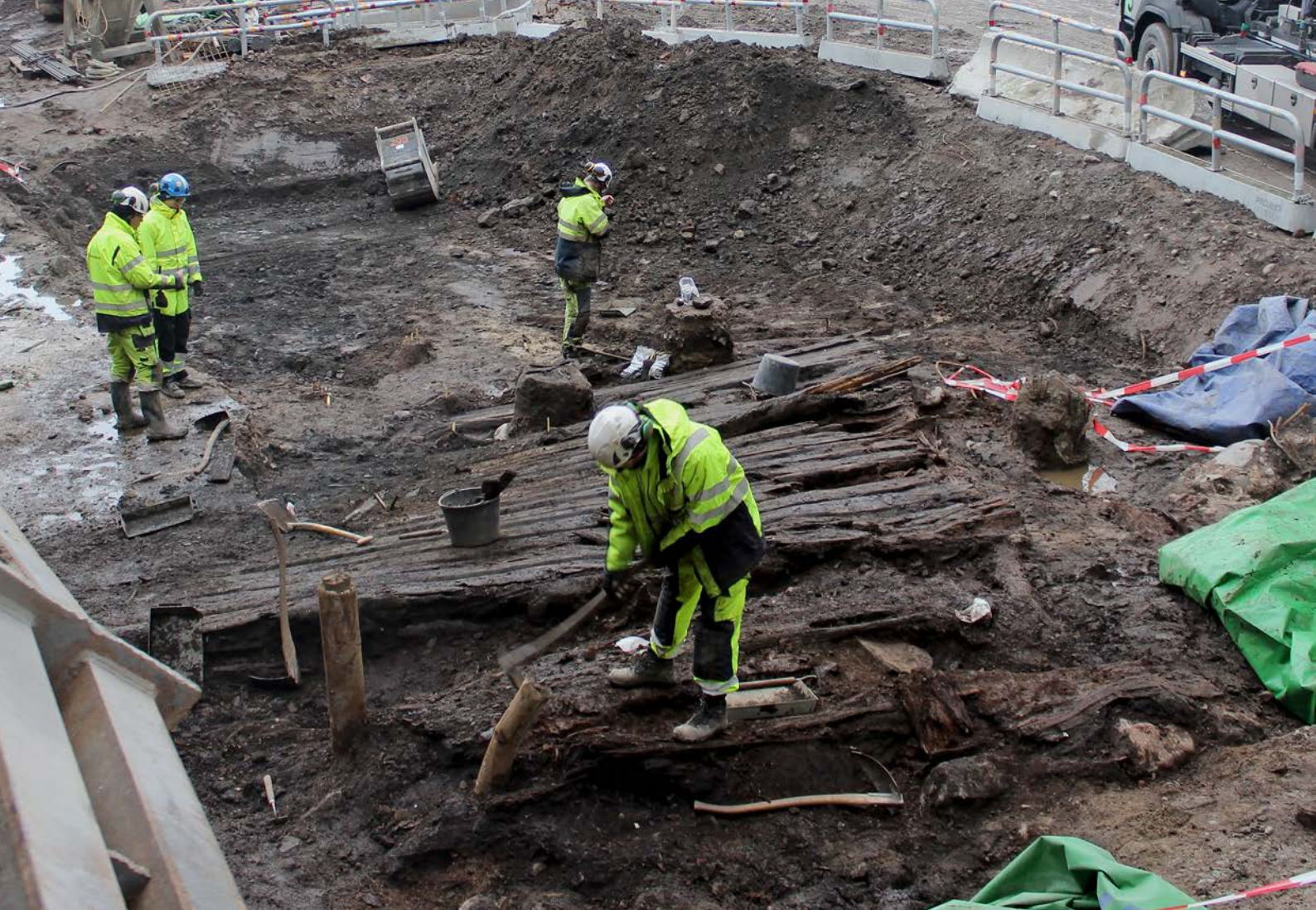
Figur 396. Framrensning av den lastkaj (kontextgrupp 16) som uppfördes direkt över en tranbod under åren runt 1615. Lastkajen togs sedan ur bruk i samband med att området fylldes ut under åren kring 1640.
