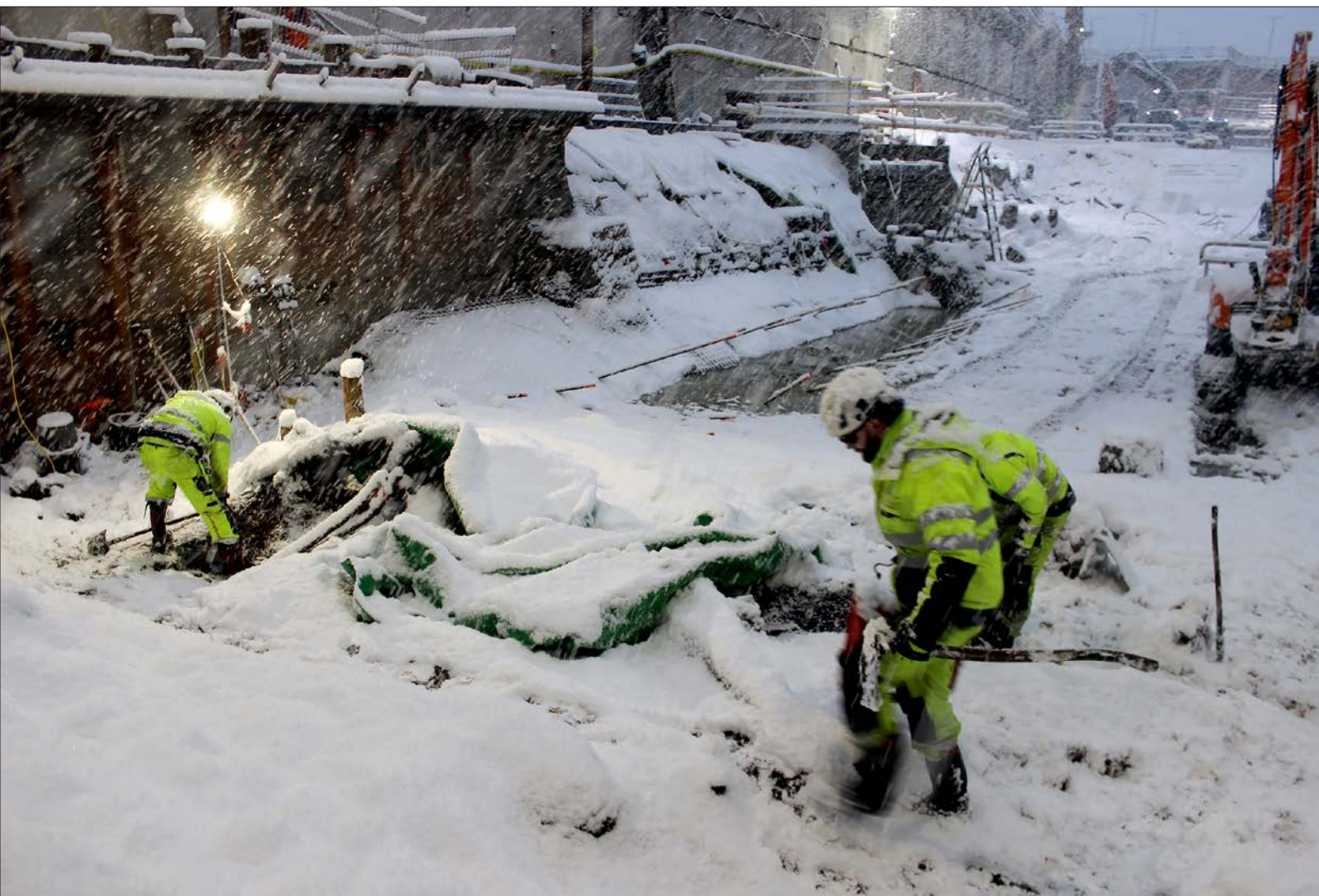
Figur 12. Arbetsbild från Stadsgården vintern 2017. Undersökningarna pågick i alla väderlekar. Under den snötäckta presenningen låg en nästan intakt lastkaj från 1600-talets första decennier.
