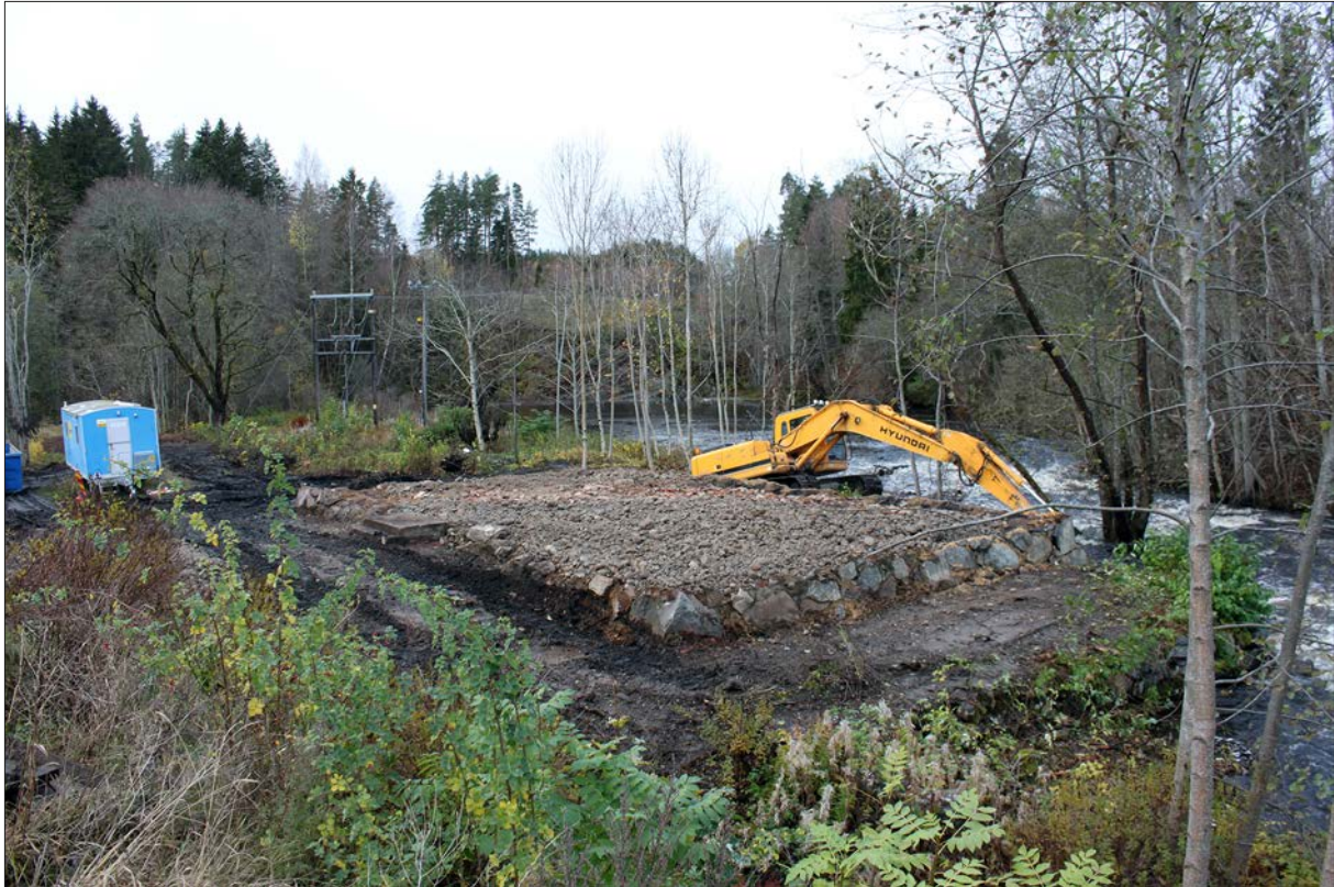
Figur 29. Efter att huset rivits täcktes husgrunden med småsten. Foto från nordost.
