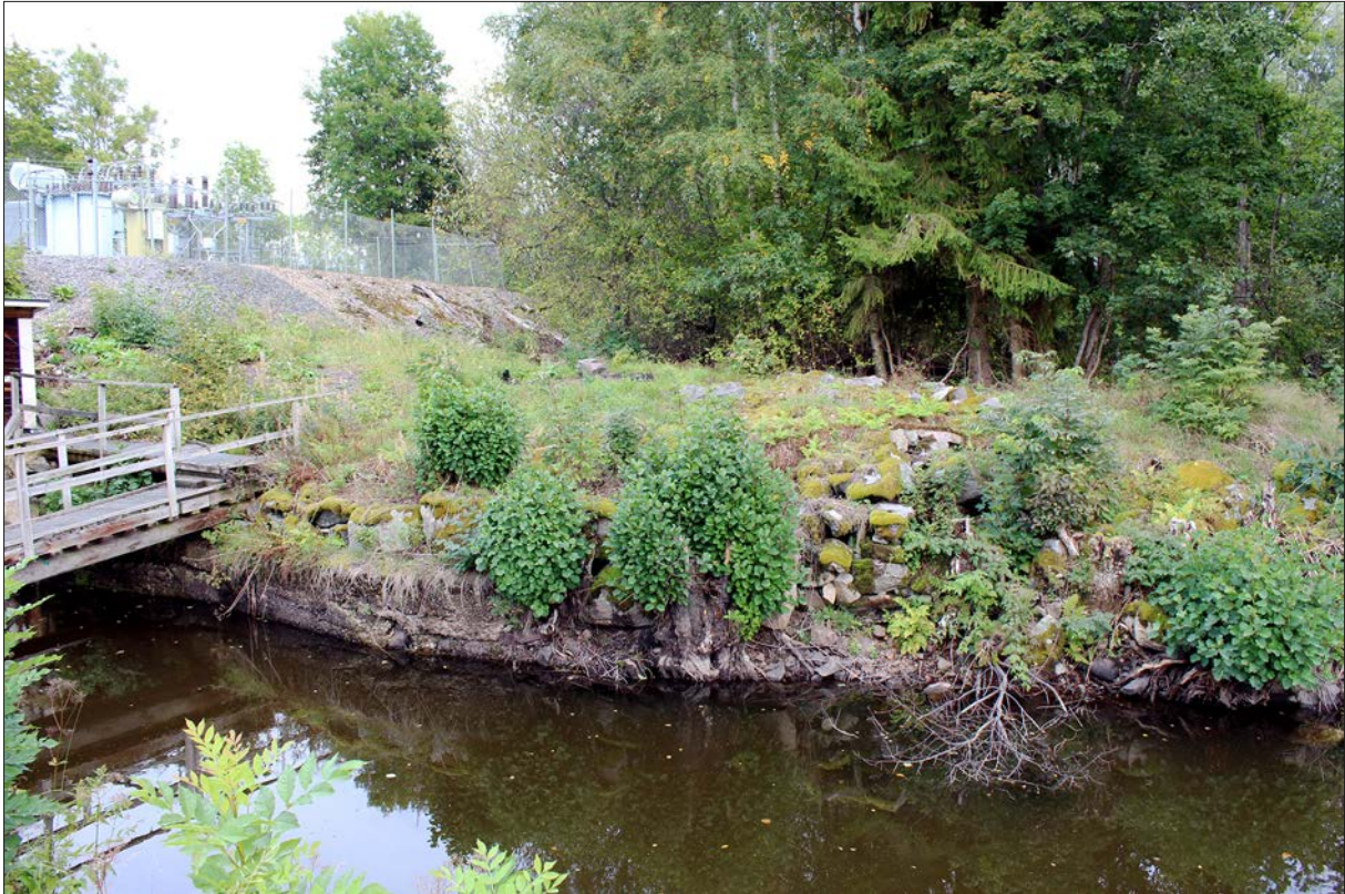
Figur 33. Stensatt kant ovanför utloppet från kraftstationen. Foto från väster.
