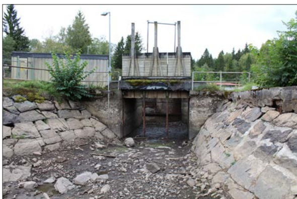
Figur 23. Vattenrännan som ledde vattnet ned mot kraftstationen hade stensatta slänter och botten. Foto från nordväst.
