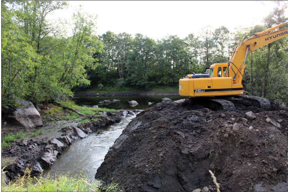
Figur 14. Inledningsvis leddes vattnet om genom en ny öppning i dammvallen. Foto från väster.
