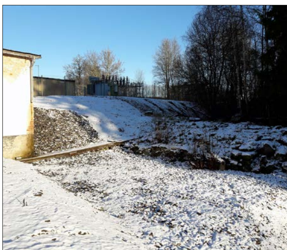
Figur 35. Vattenrännan vid kraftstationen fylldes igen. Till vänster syns den nu tömda kraftstationen. Foto från sydväst.
