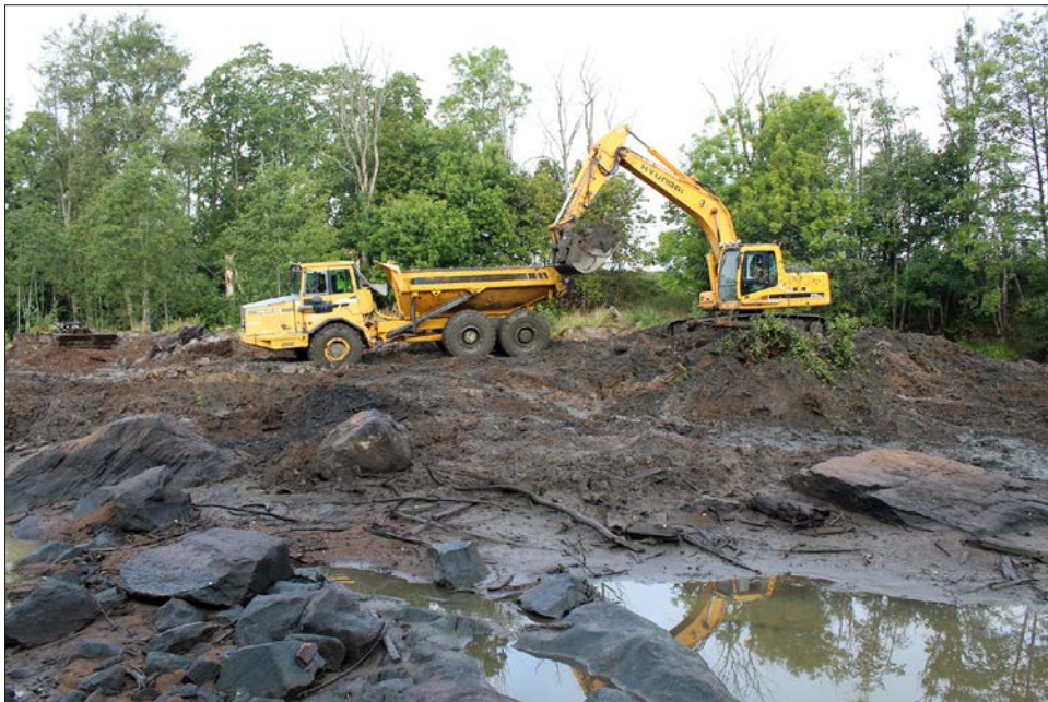
Figur 15. Massorna från dammvallen användes för att fylla igen vattenrännan och delar av den tidigare dammen. Foto från sydost.
