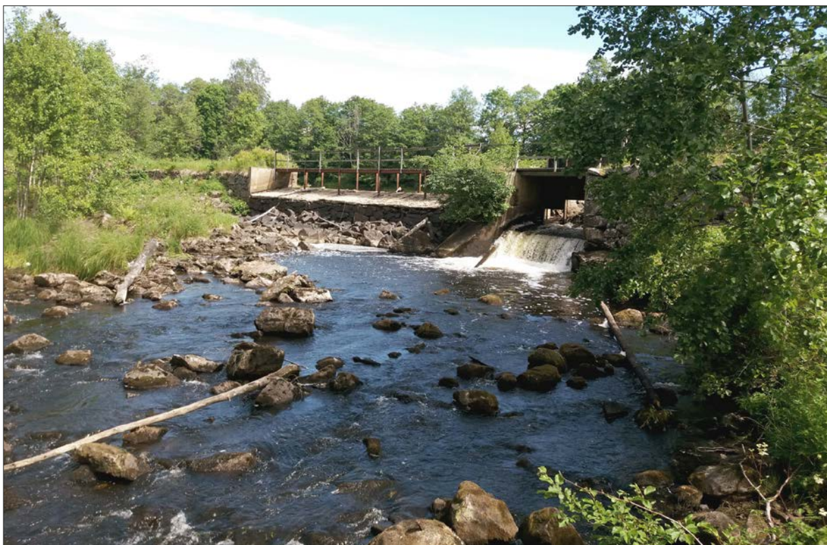
Figur 20. Ett av utskoven var torrlagt vid undersökningstillfället. Foto från sydväst. Foto: Sigrid Tuvall, WSP.
