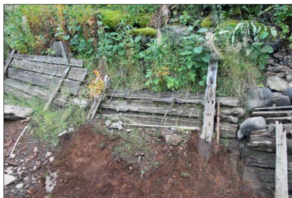
Figur 24. I damms södra kant fanns en träkonstruktion som sannolikt härstammar från tiden då timmer flottades till sågen. Foto från nordväst.
