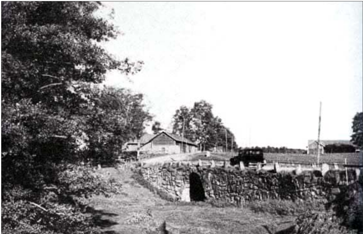
Figur 9. Den lokala topografin vid undersökningsområdet har påverkats kraftigt av lertäkt och anläggandet av Rikssexan på 1940-talet. Bilden är tagen från väster innan dessa omdaningar där den ursprungliga mjuka slänten ner mot Hovaån kan anas framför stenvalsbron. Källa: Okänd fotograf/Hova hembygdsförening.
