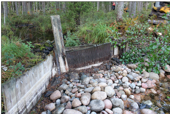
Figur 14. Träkonstruktionen i dammvallens öppning innan borttagandet. Lekgrus hade påförts mot sjösidan. Foto från norr.
