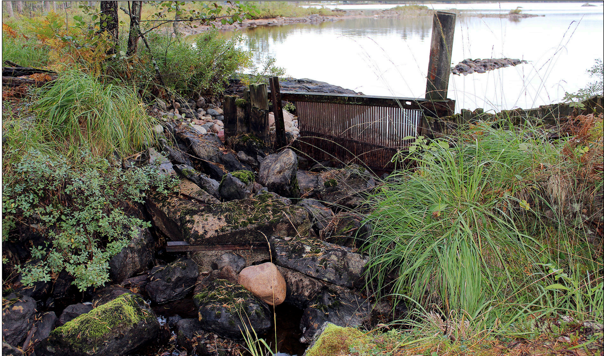
Figur 13. Träkonstruktionen i dammvallens öppning innan arbetena vidtog. Foto från söder.
