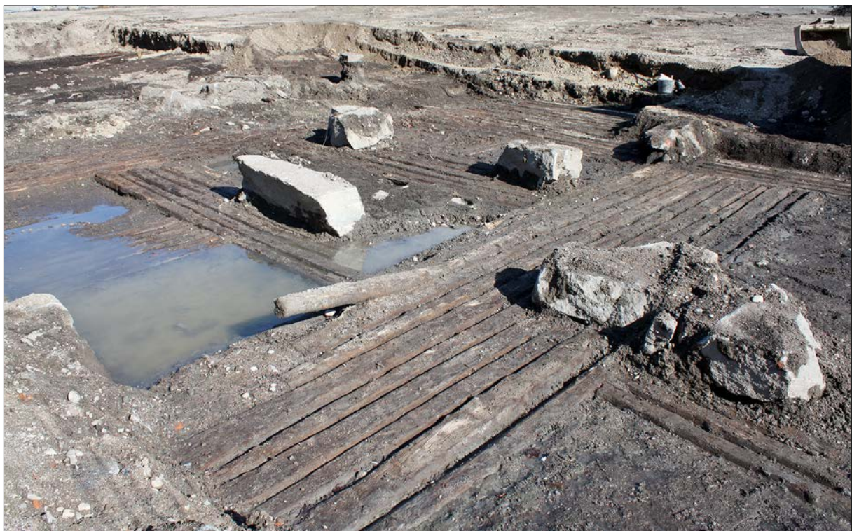
Figur 303. Rustbädd och stensyllar för hus 157. Foto från söder.
