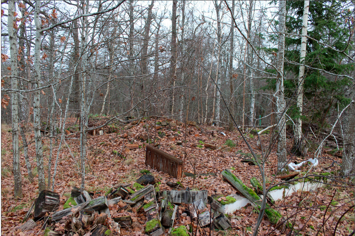
Figur 19. Rester av det rivna huset i norr. Foto från sydväst.
