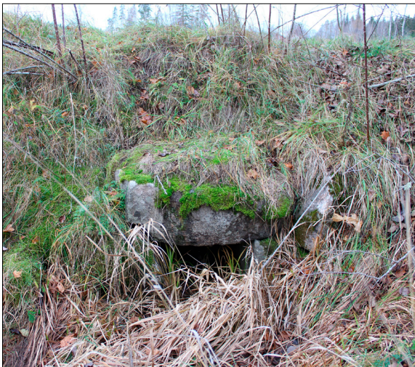
Figur 18. Kulvert under den gamla landsvägen. Foto från sydöst.
