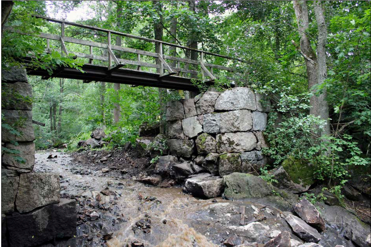
Figur 22. Västra utskovet efter utrivningen. Foto från sydväst.
