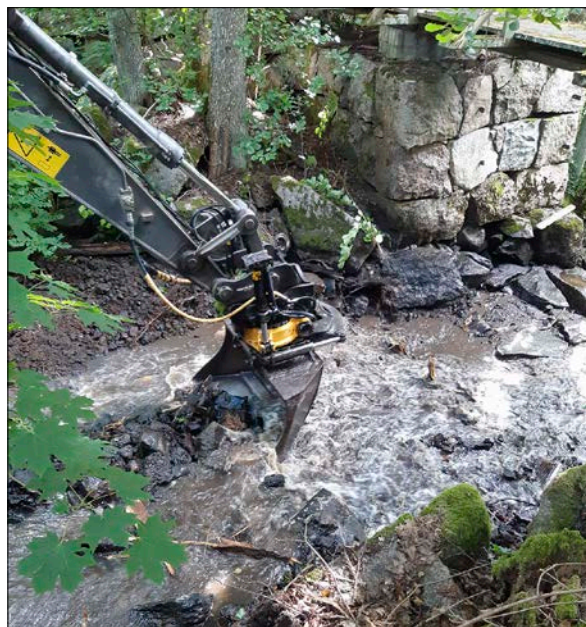
Figur 14. Maskinen gräver i åns botten ovanför utskovet. Foto från nordväst.
