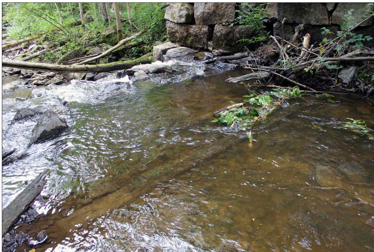
Figur 21. I utskovets övre, norra kant fanns en träkonstruktion. Foto från nordost.
