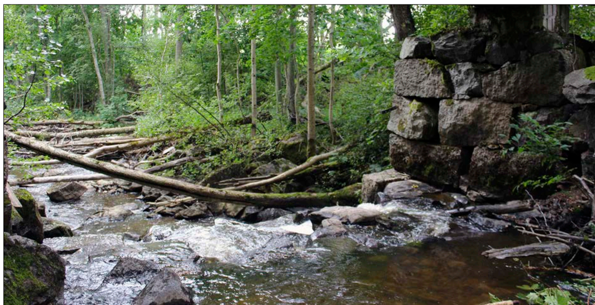
Figur 20. Västra utskovet innan utrivningen. Foto från nordost.
