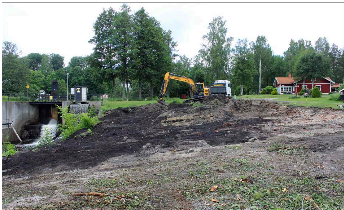
Figur 17. Arbetet inleddes med att ytan banades av. Foto från söder.
