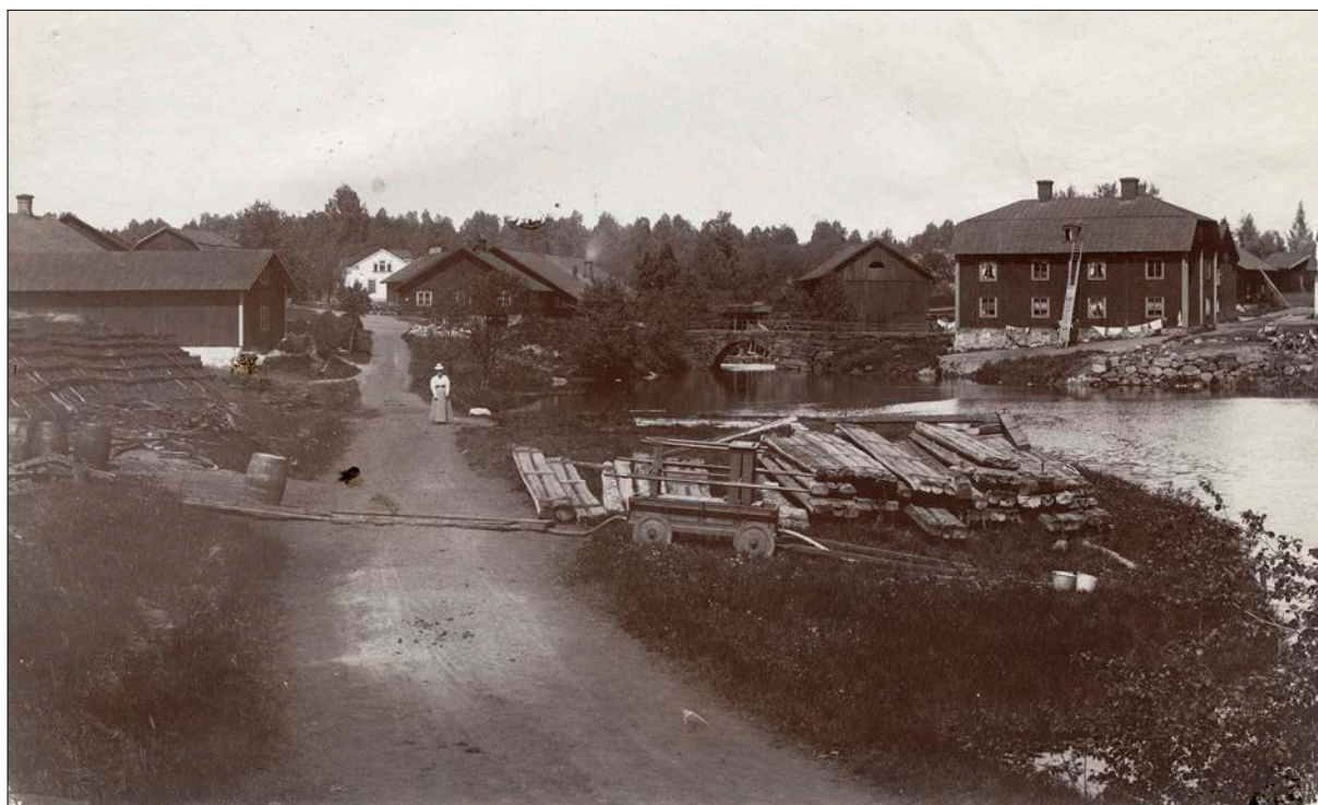
Figur 25. Gisslarbo bruk 1901. Sågbyggnaden är den med det halvmåneformade fönstret direkt till höger om valvbron. Bild från tidskriften Hemmets bildmaterial. Källa: Tekniska Museet, fotograf okänd. T. Bildid: TEKA0125527. Public Domain 1.0.
