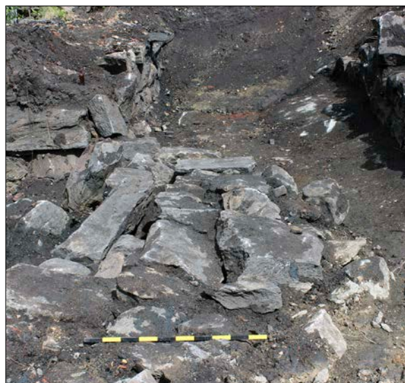
Figur 23. Fundamentet för vattenhjulet (111/112). Foto från söder.
