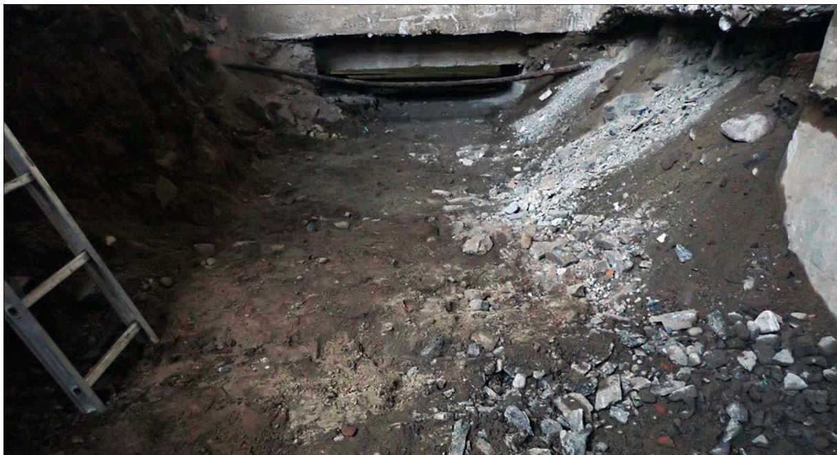
Figur 13. Ledningsschakt i yta B. Foto från norr.
