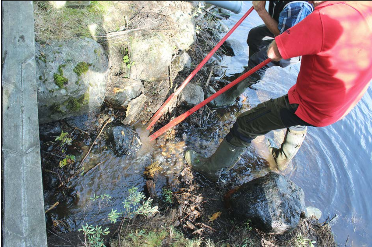
Figur 4. Öppningen i dammvallen gjordes för hand med spett och spade. Foto från sydost.
