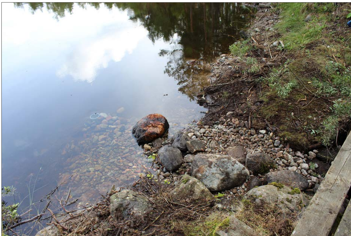
Figur 13. Ett plaströr lades ned för att öka utflödet och täcktes över med sten, grus och sand. Foto från väster.
