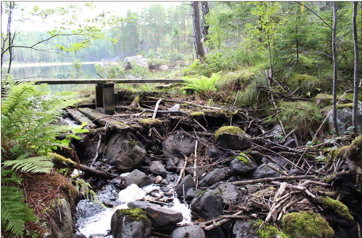
Figur 10. Den sydöstra bäckfåran med utrivna delar av dammvallen. Foto från sydväst.
