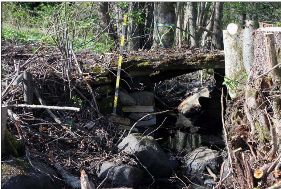
Figur 36. Kalkstensbron över Hållsdammsbäcken. Foto från nordväst.
