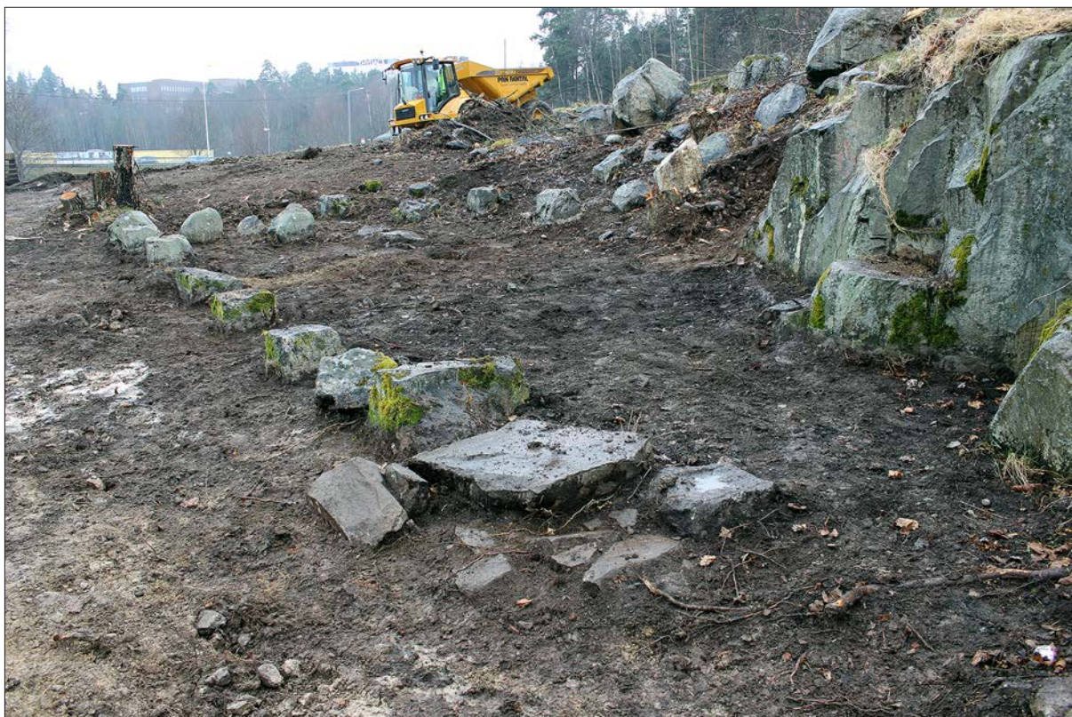
Figur 14. Hus 4 där grunden utgjordes av ett antal stenplintar. Foto från NÖ.
