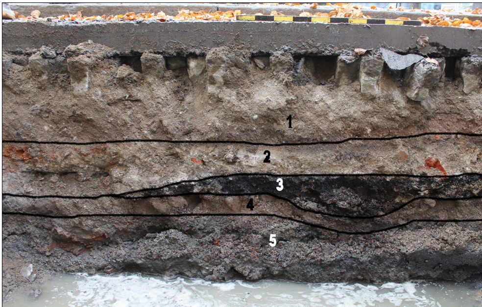
Figur 5. Lagerföljden i den SV schaktväggen i schakt 1: 1. Fyllnadsmaterial till väg. 2. Utfyllnadslager med mycket kalkbruk och tegelkross. 3. Svart kollager. 4. Sandigt utfyllnadslager med ett flertal rundade stenar, cirka 0,1–0,15 meter stora. 5. Vattenavsatt, sandigt och grusigt utfyllnadslager med mycket tegelkross. Foto från NO.
