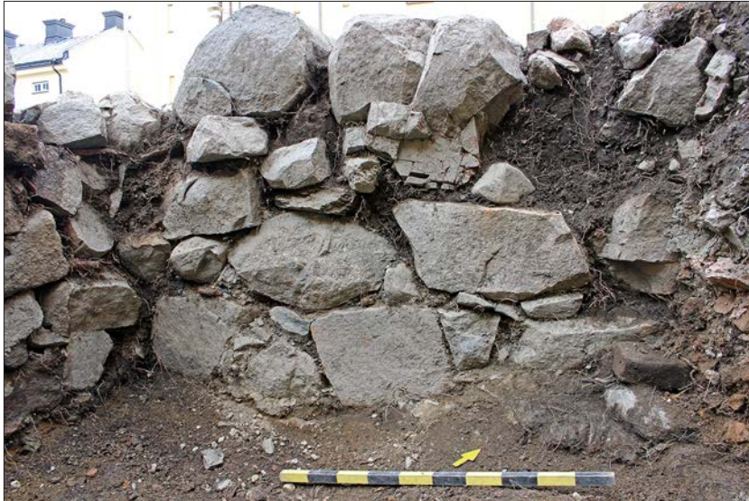
Figur 79. Källare (grupp 10), murens norra sida med hörnet i nordväst till vänster i bild. De större blocken är lagda i relativt jämna men glesa skift och murlivet är ojämnt. Foto från SÖ.
