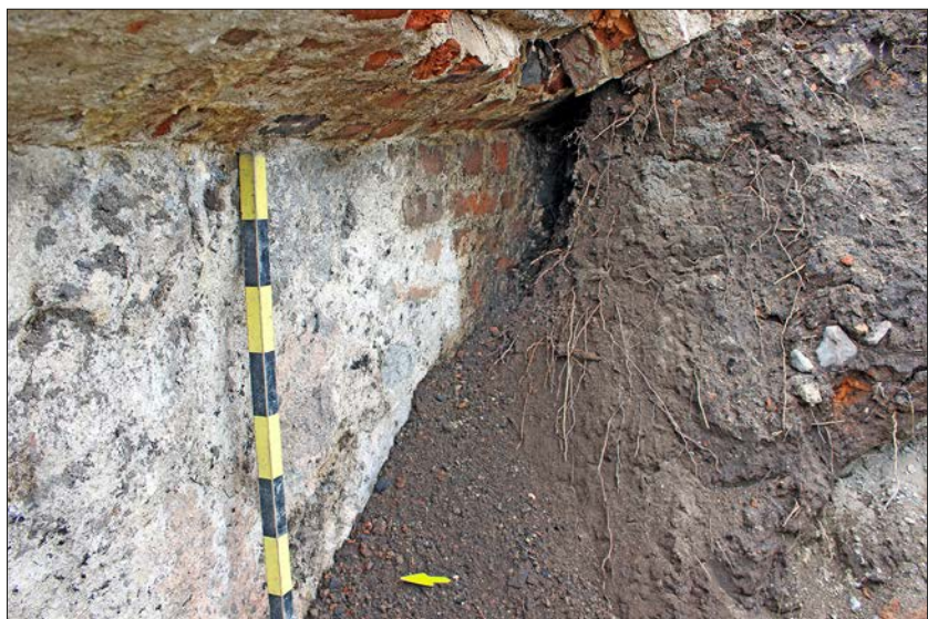
Figur 138. Källare (grupp 15), väggen mot nordöst, den inre delen med mur- verk av tegel.
