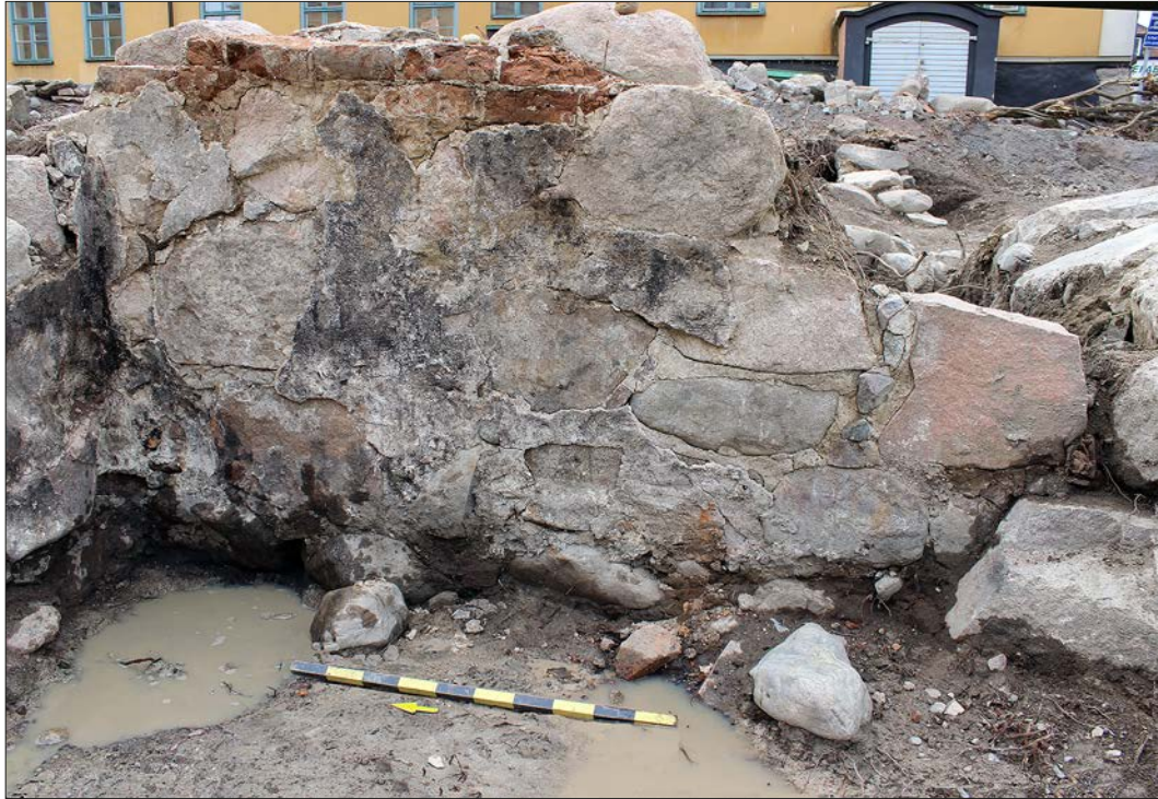
Figur 104. Källare (grupp 12) rum B sett mot öster. Muren är huvudsakligen uppförd med stora naturstensblock men högst upp ses två tegelskift.
