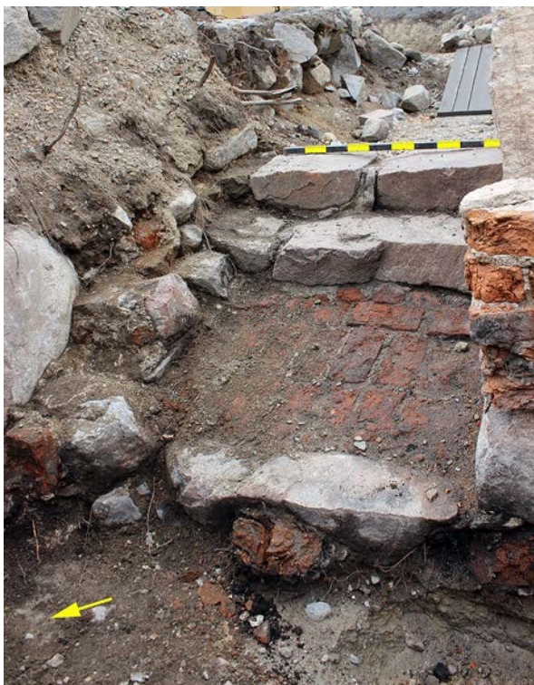
Figur 98. Källare (grupp 12), trappan upp från rum A sett mot öster. Nedanför det nedersta steget ses rester av tegel, möjligen från ett tegelgolv.
