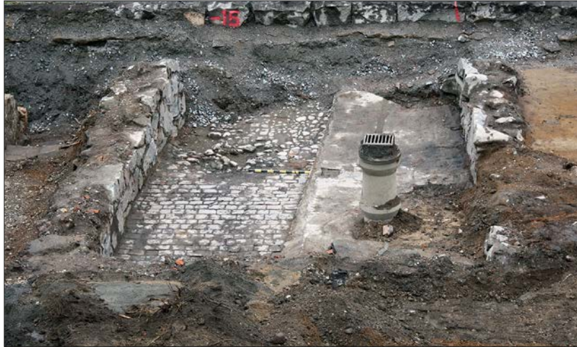
Figur 189. Källargrund grupp 21. Till vänster i bild syns ett nedsänkt stenlagt golv (KK 118) och till höger ett gjutet betonggolv (KK 117). Foto från S.
