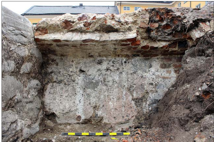
Figur 137. Källare (grupp 15), väg- gen mot nordöst är murad med tegel och natursten. En del av rummets tunnvalv är bevarat.
