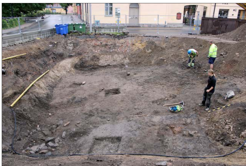
Figur 57. Utfyllnadslager KL 312 framschaktad. Lagret täckte hela västra delen av undersökningsytan. I schaktväggen kan man se utfyllnadslager KL 294 som var upp till 0,7 meter tjockt och utgjordes av sandig grus. Foto från S.
