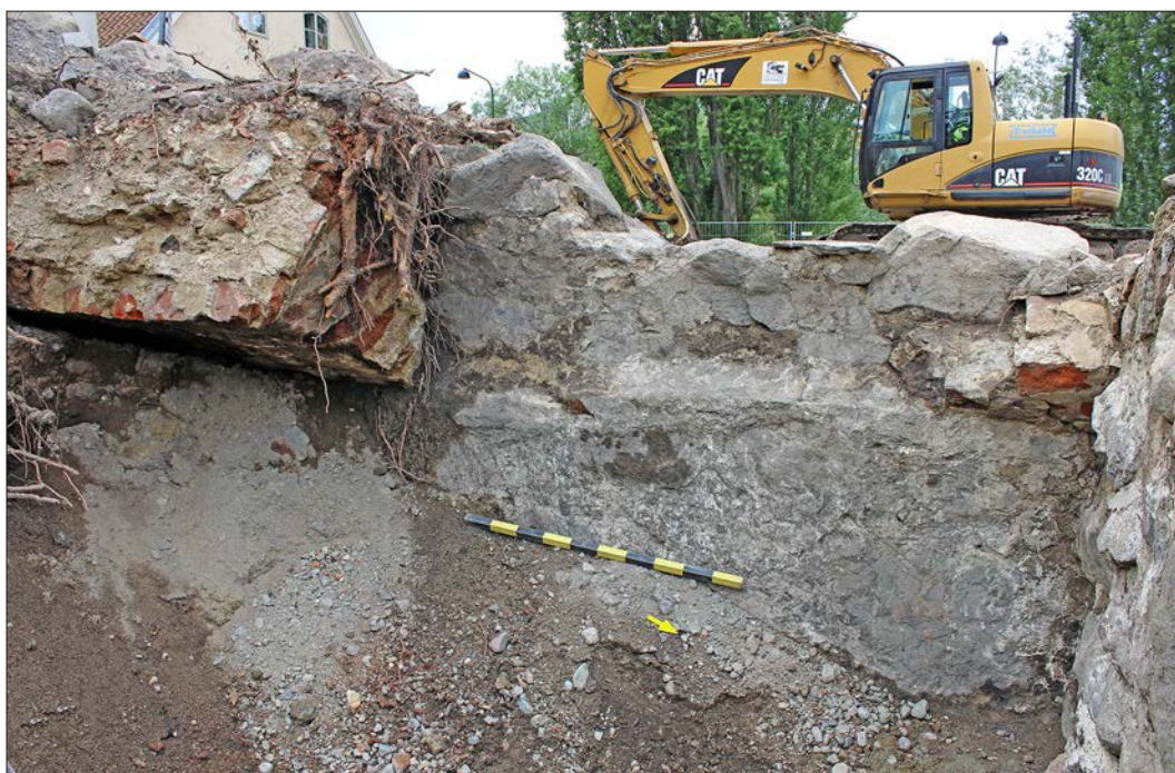
Figur 139. Källare (grupp 15). Väggen mot sydväst med delar av tunnvalvet bevarat.
