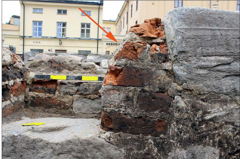
Figur 136. Källare (grupp 15), smyg- sidan till en av nischerna i den nord- västra väggen. Pilen markerar fogen mot en borttagen valvsten.
