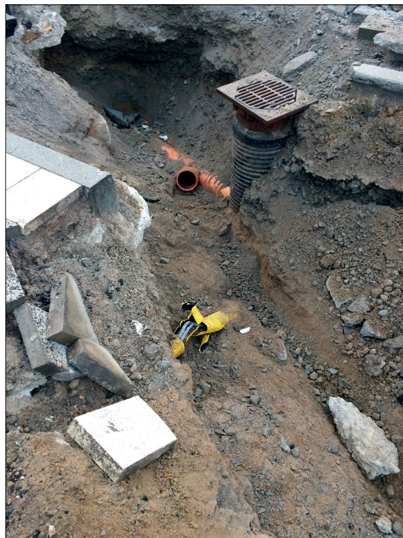
Figur 5. Djupschaktet vid södra Blasieholmskajen. Foto från NO. Foto: Amanda Landin, PEAB.
