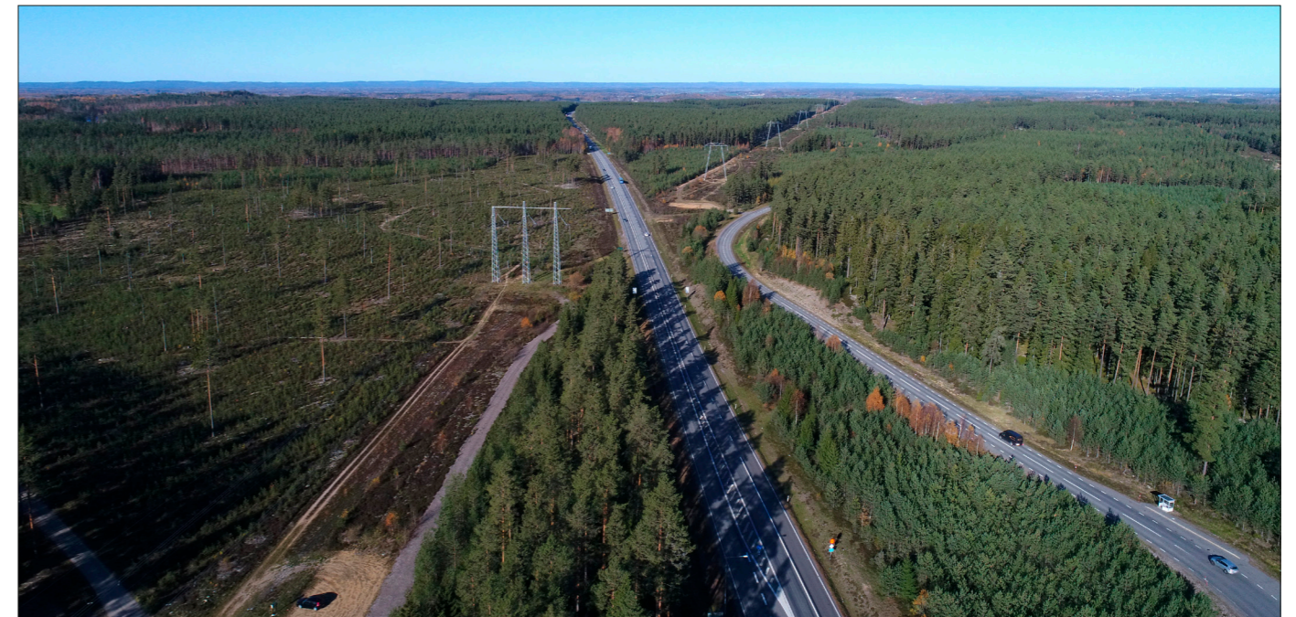
Figur 30. Väg 50 skär genom sandiga tallmoar och korsas av en luftledning, Sydvästlänken. Talrika kolningslämningar ligger i området och har påträffats både längs vägen och luftledningen. Till höger syns den gamla landsvägssträckningen. Foto från söder.
