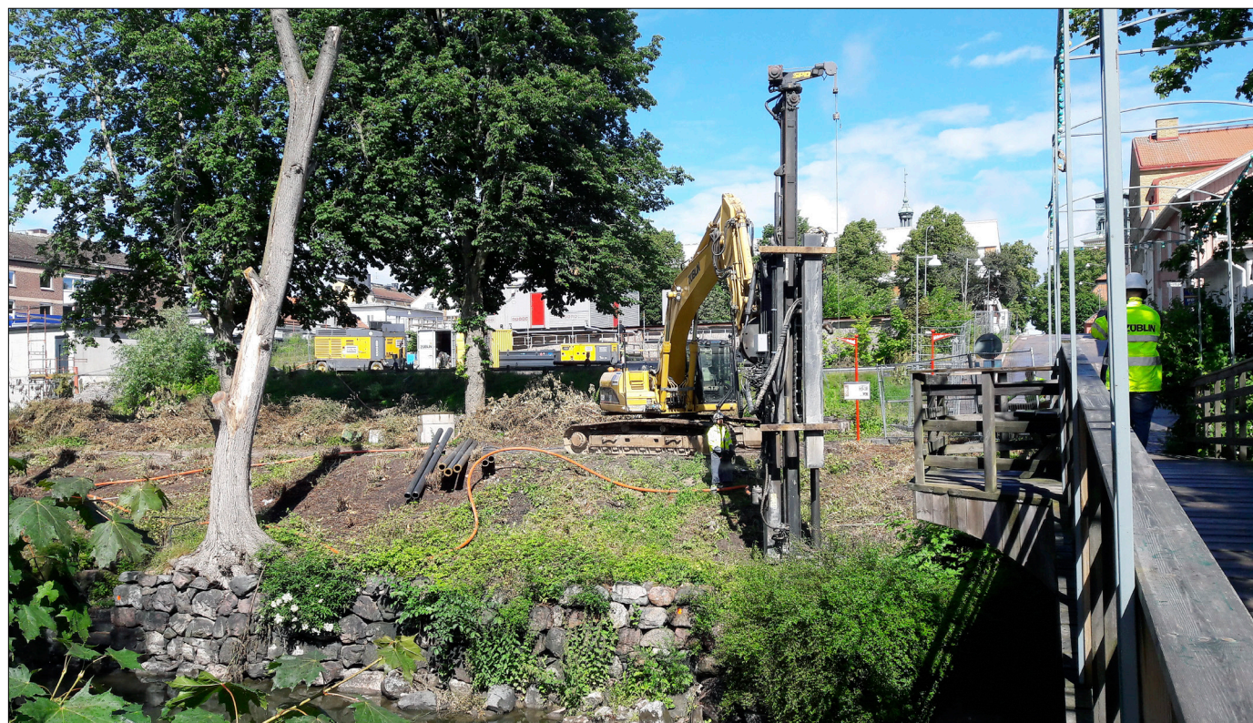
Figur 3. Borrning av stagrör påbörjad. Foto från sydöst.
