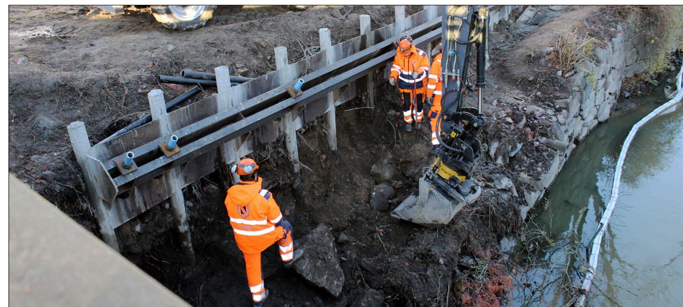
Figur 36. Nedmontering av strandskoningen öster om Behmbron. Foto från sydväst.
