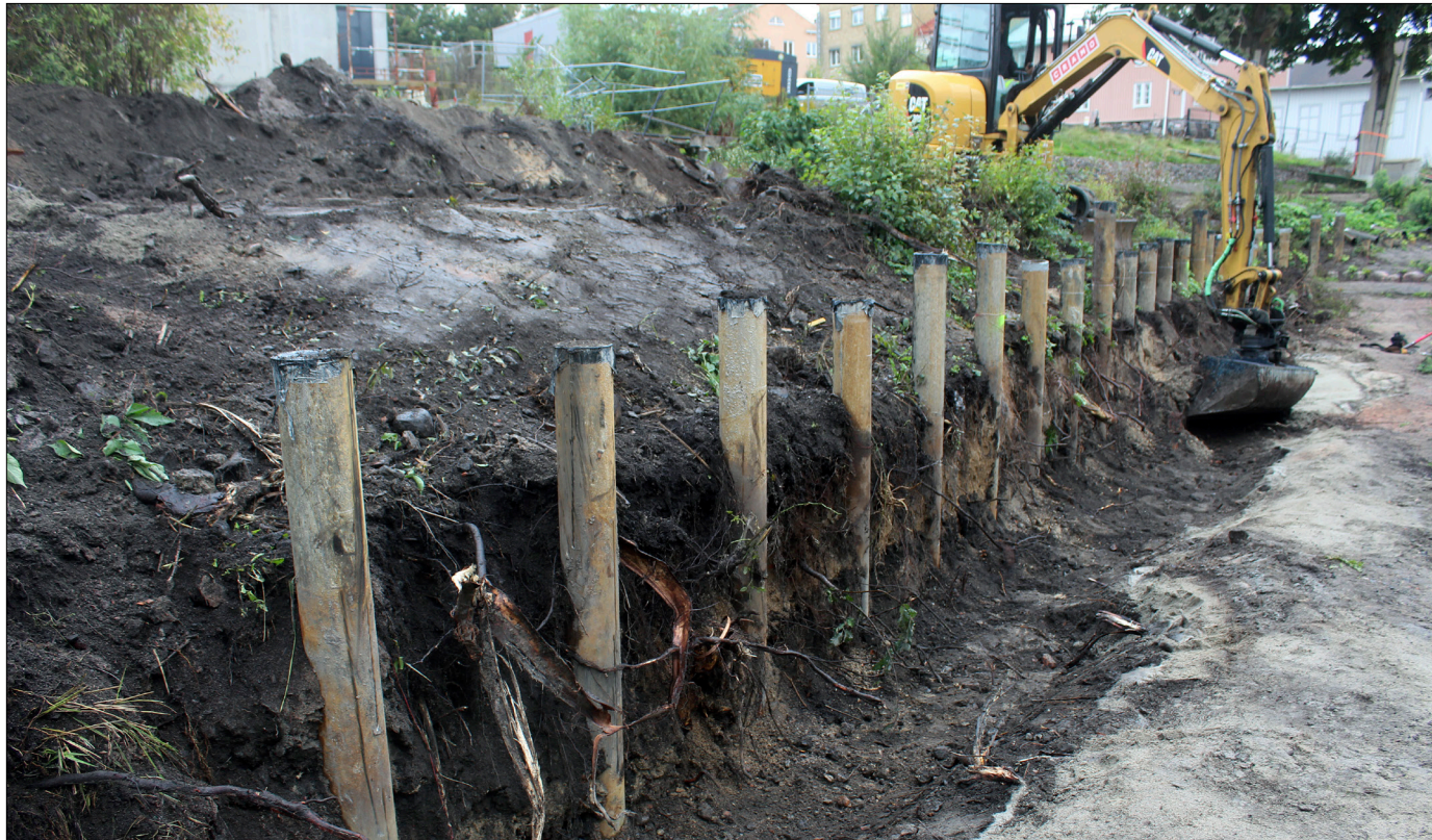
Figur 9. Schaktningsövervakning etapp 1. Foto från sydväst.
