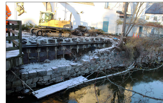
Figur 37. Uppbyggnad av strandskoningen öster om Behmbron. Foto från sydväst.
