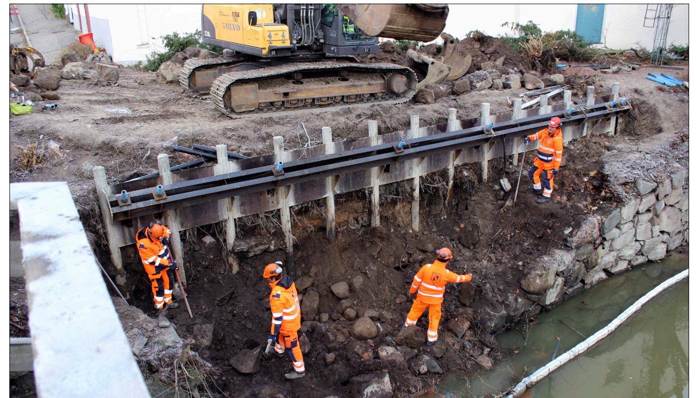
Figur 12. Nedmontering av östra strandskoningen. Foto från sydväst.
