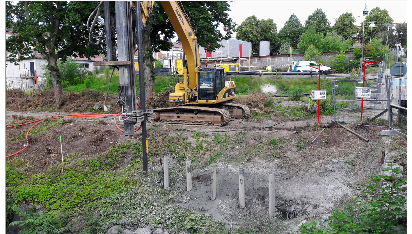
Figur 11. Boring av stagrör påbörjades väster om Behmbron. Foto från sydöst.
