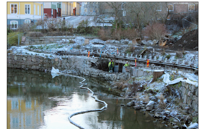
Figur 41. Arbete pågår med att nedmontera delar av strandskoningen i väster. Foto från öster.
