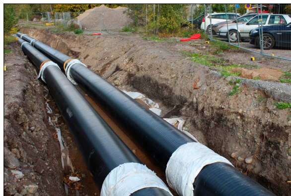
Figur 11. Fjärrvärmerören hade lagts på plats i schakten då besiktningen utfördes. Foto från söder.
