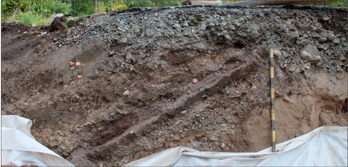
Figur 17. Järnvägsbanken var uppbyggd av fyllnadsmassor som lagts i olika lager. Foto från norr.
