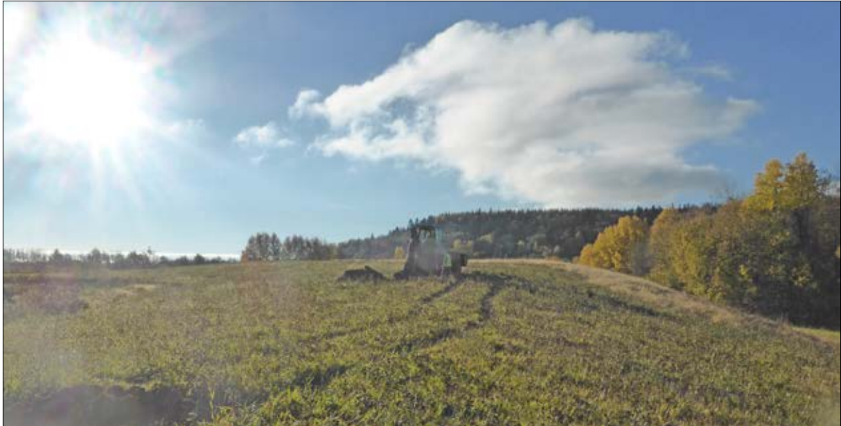
Figur 19. Schaktning söder om Brandstorpsvägen. Foto från N.
