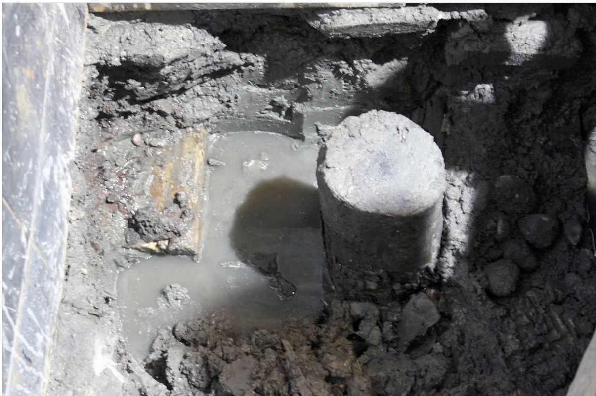
Figur 5. Foto av andra provgropen med träplank högst upp i bild, rustbädd i nedersta vänstra hörnet och den påle som borrhö provet togs på centralt i bild.
