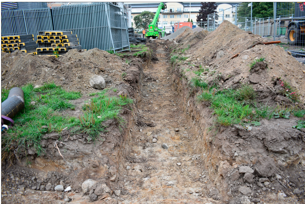
Figur 5. Del av schakt 4, det längre schakt som grävdes för att koppla samman de rör som borrats ned för fjärrvärme. Foto taget från öster.
