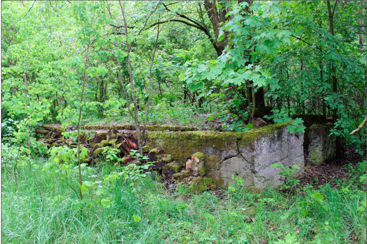
Figur 10. En av husgrunderna i objekt 4. Foto från nordväst.
