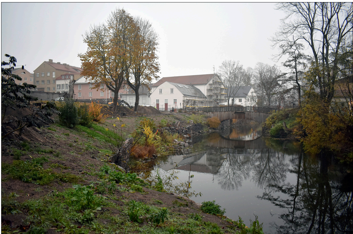
Figur 10. Åröken från väster med schaktområde och Behmbron i bakgrunden. Foto från väster.
