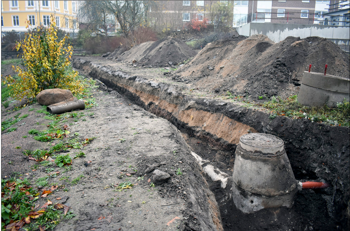
Figur 9. Västra delen av schakt 1000 med avloppsledning och brunn. Foto från öst.
