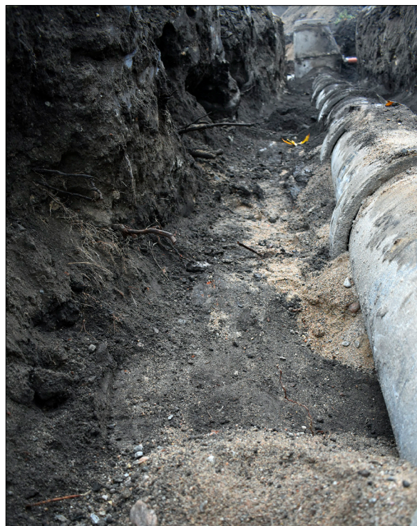
Figur 8. Schakt 1000 med ytan under avloppsledningen synlig vid underökningen av provgropar. Foto från öster.
