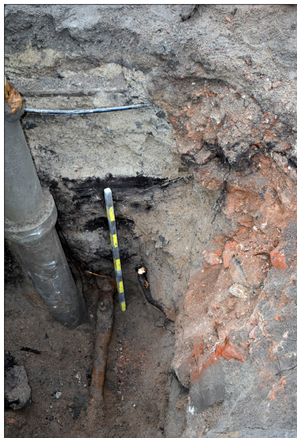
Figur 3. Schakt 3000 med frilagd vattenventil på 1,7 meters djup, raseringslager med tegel till höger i bilden. Foto från väster.
