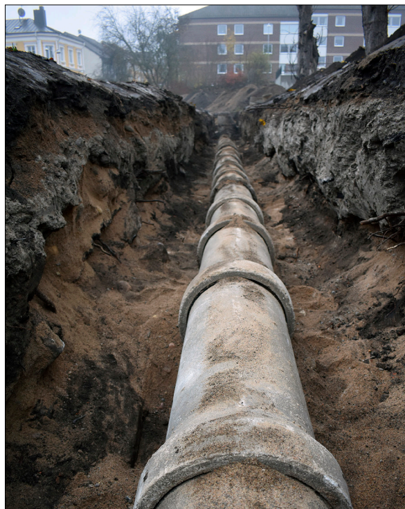
Figur 7. Frilagd avloppsledning, mot botten syns med den äldre nedgrävningskanten tydligt mot den gul/bruna sanden som använts för att återfylla schaktet. Foto från öster.
