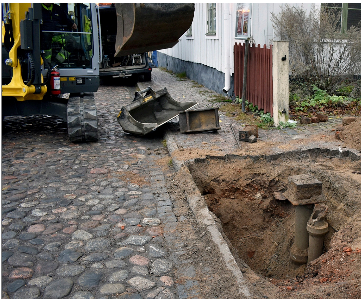
Figur 15. Schaktning vid Behmbrogatan pågår (schakt 3000). Foto från söder.
