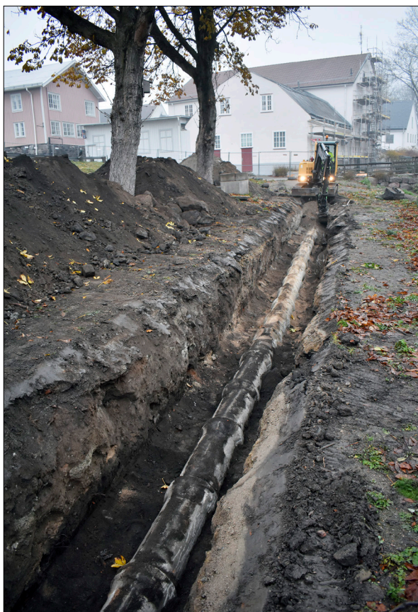
Figur 2. Schakt 1000, arbetet pågår med att frilägga avloppsledningen vid Behmbron. Foto från väster.
