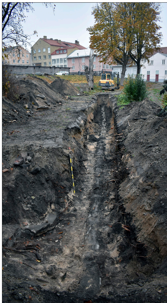
Figur 11. Schakt 1000 med frilagd avloppsledning i väster, raseringslager med stora stenar i förgrunden. Foto från väster.
