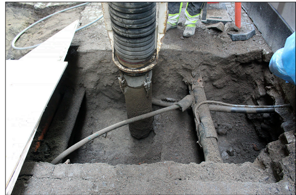
Figur 4. Massor avlägsnas och ledningar tas fram i Prästgatan med hjälp av grävsug. Foto från söder.
