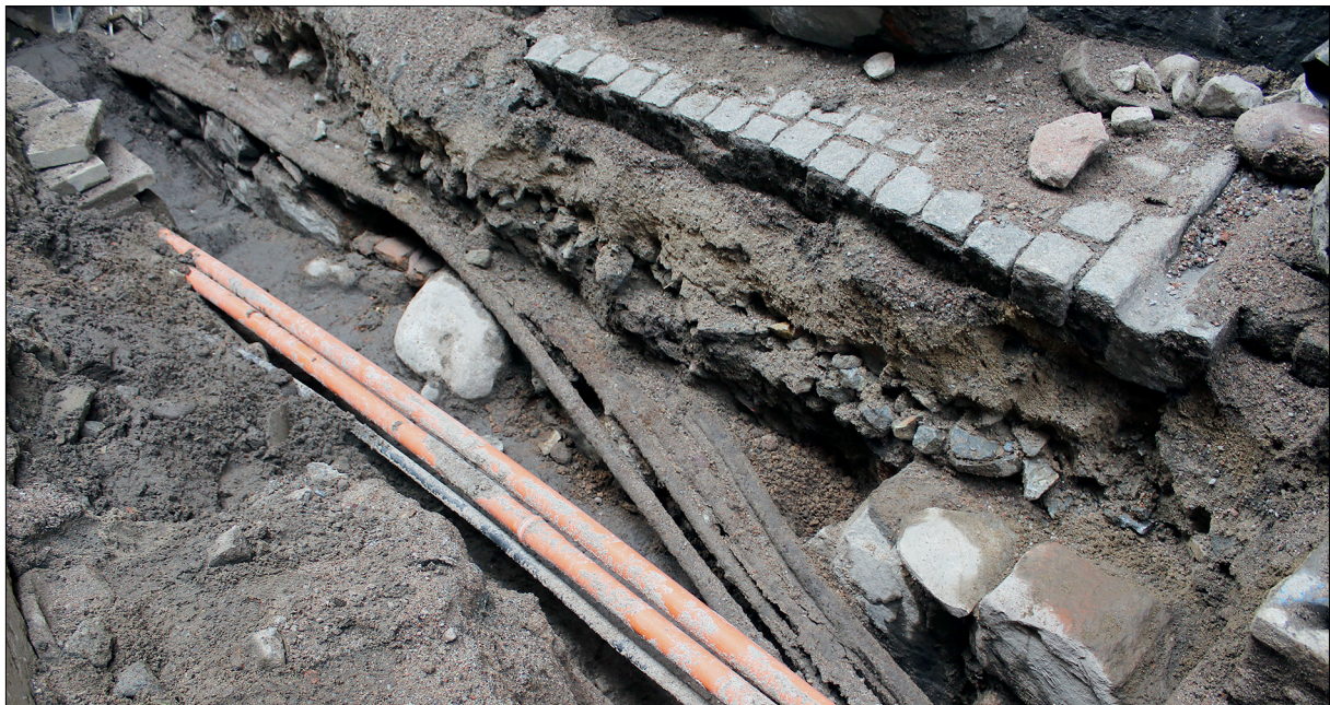
Figur 18. Översikt över mur 150, och det ledningsstråk som lagts ovan denna. Foto från nordost.
