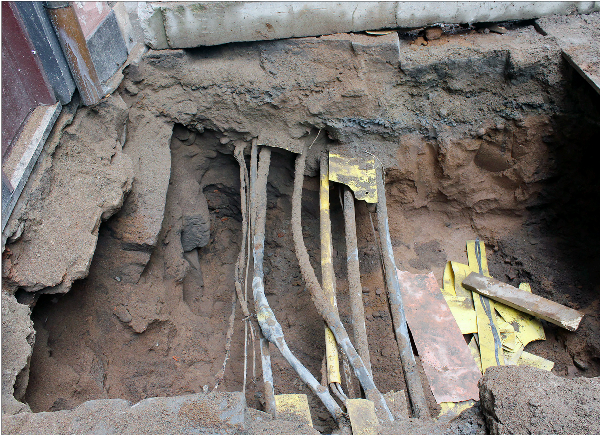
Figur 8. Västra delen av schakt 1 som grävdes vid Trångsund. Till vänster i bild i norra profilväggen, syns lagerrest 154 som påträffades närmast husväggen. Till höger syns delar av lager 153. Foto från söder.
