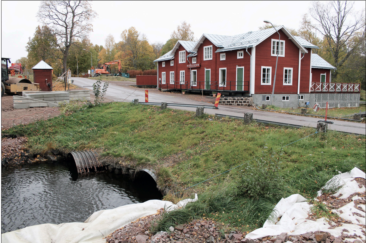
Figur 21. Bron innan arbetet påbörjades. I bakgrunden syns den gamla handelsboden som nu fungerar som besökscentrum för Ekomuseum Husbyringen. Foto från sydost.
