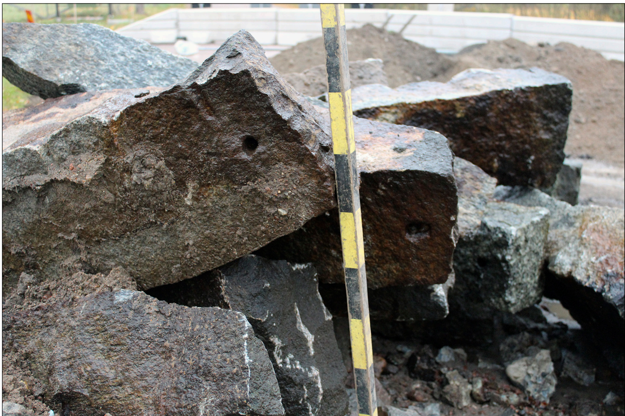
Figur 22. Stenarna i brokonstruktionen hade borrarade hål och var uppenbart återanvända.
