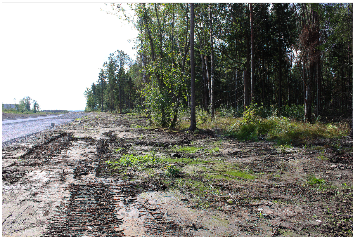
Figur 8. Utschaktade ytor för Kardonbanans godsbangård längs nordöstra delen av område D. Foto från nordväst.
