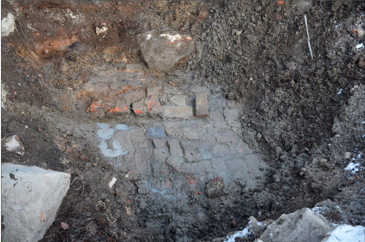
Figur 23. Den tegelkonstruktion (147) med flera tegelskift som hittades i schakt ett. Foto från väster.
