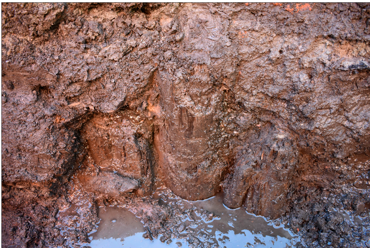
Figur 32. De tre pålar som framkom i västra schaktväggen i botten av schakt 2. Foto från nordost.
