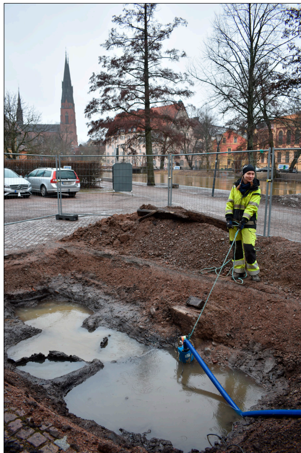
Figur 3. Vid undersökningen blev schakt två vattenfyllt på grund av rådande väderlek, samt Fyrisåns höga vattennivå. Detta åtgärdades med hjälp av en vattenpump. Foto från norr.
