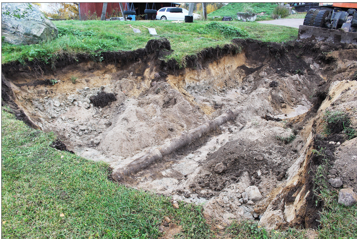
Figur 9. Det schakt som togs upp på området mellan de båda gravfälten. Ledningen framrensad. Överst i bild syns den plana yta som sannolikt skapats med påförda massor. Till vänster i bild anas det omrörda lagret i profilväggen. Foto taget från sydost.
