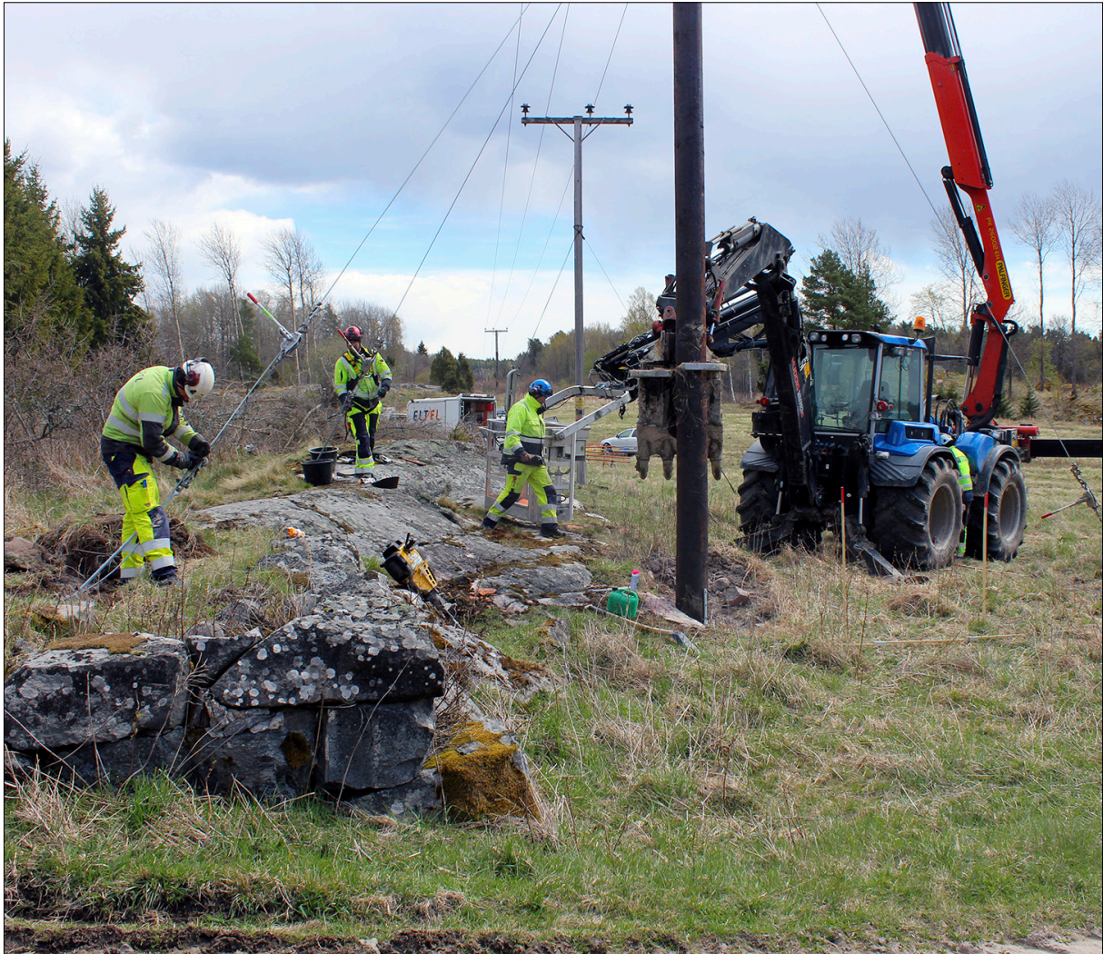
Figur 17. Stolpe 170 har ställts på plats och vajrana har dragits åt. I förgrunden, till vänster i bild, syns fundamentstenar tillhörande gaveln till ett av uthusen i Vadholmen som stått på berghällen bortåt i bild. Foto från västnordväst.
