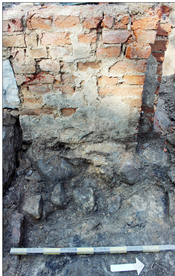
Figur 12. Under tegelväggarna (101, 102) och syllraden (103) fanns en grundförstärkning (107) bestående av natursten och siltig lera. Foto från öster.
