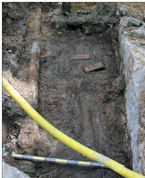
Figur 14. Det träggolv som framkom vid undersökningen (111). Foto från väster.
