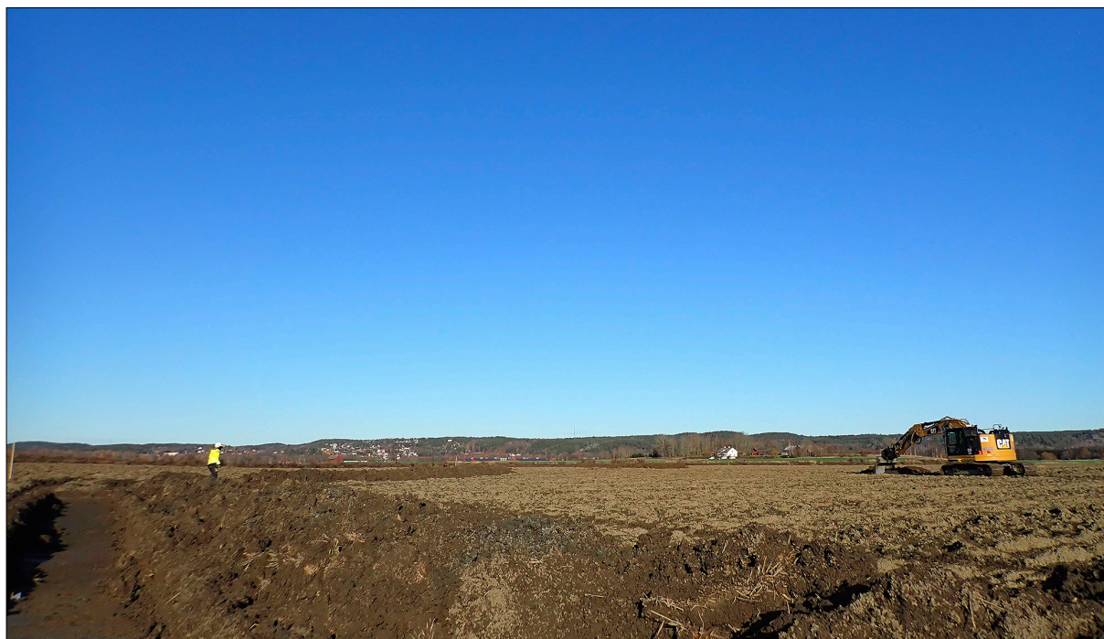
Figur 13. Schaktning i delområde 1. Foto taget från söder.
