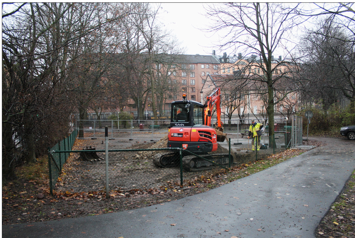
Figur 9. Schakten upptogs inom hundrastgården. Foto taget från norr.
