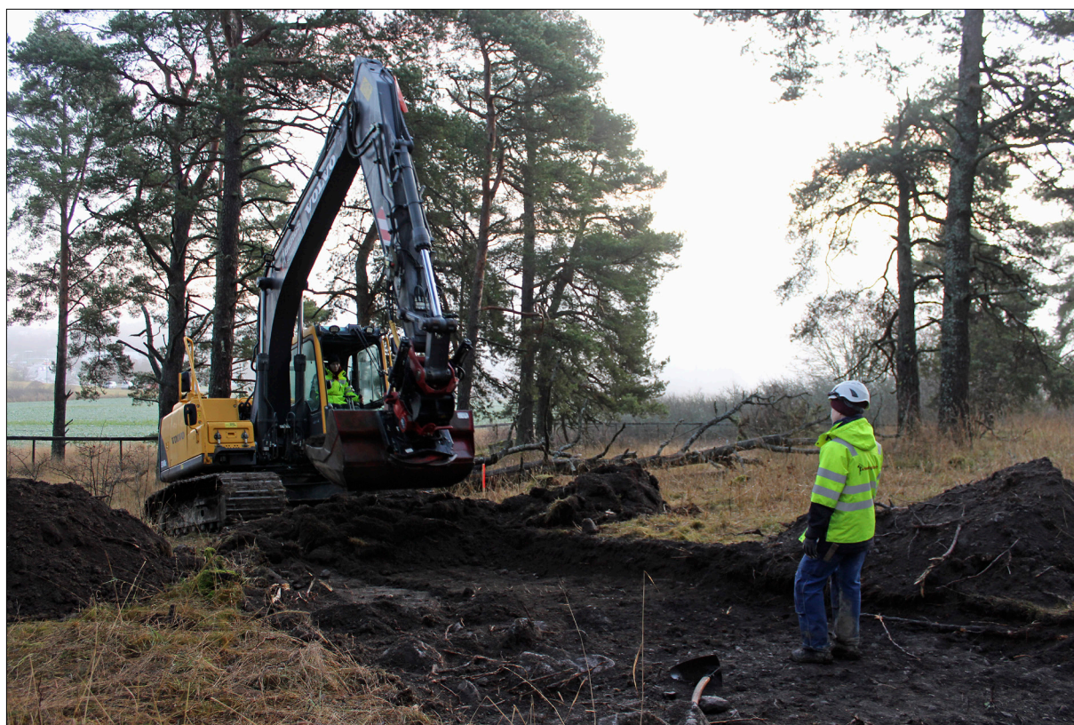
Figur 6. Sökschaktning med grävmaskin i undersökningsområdets mittersta del. Foto från väst.
