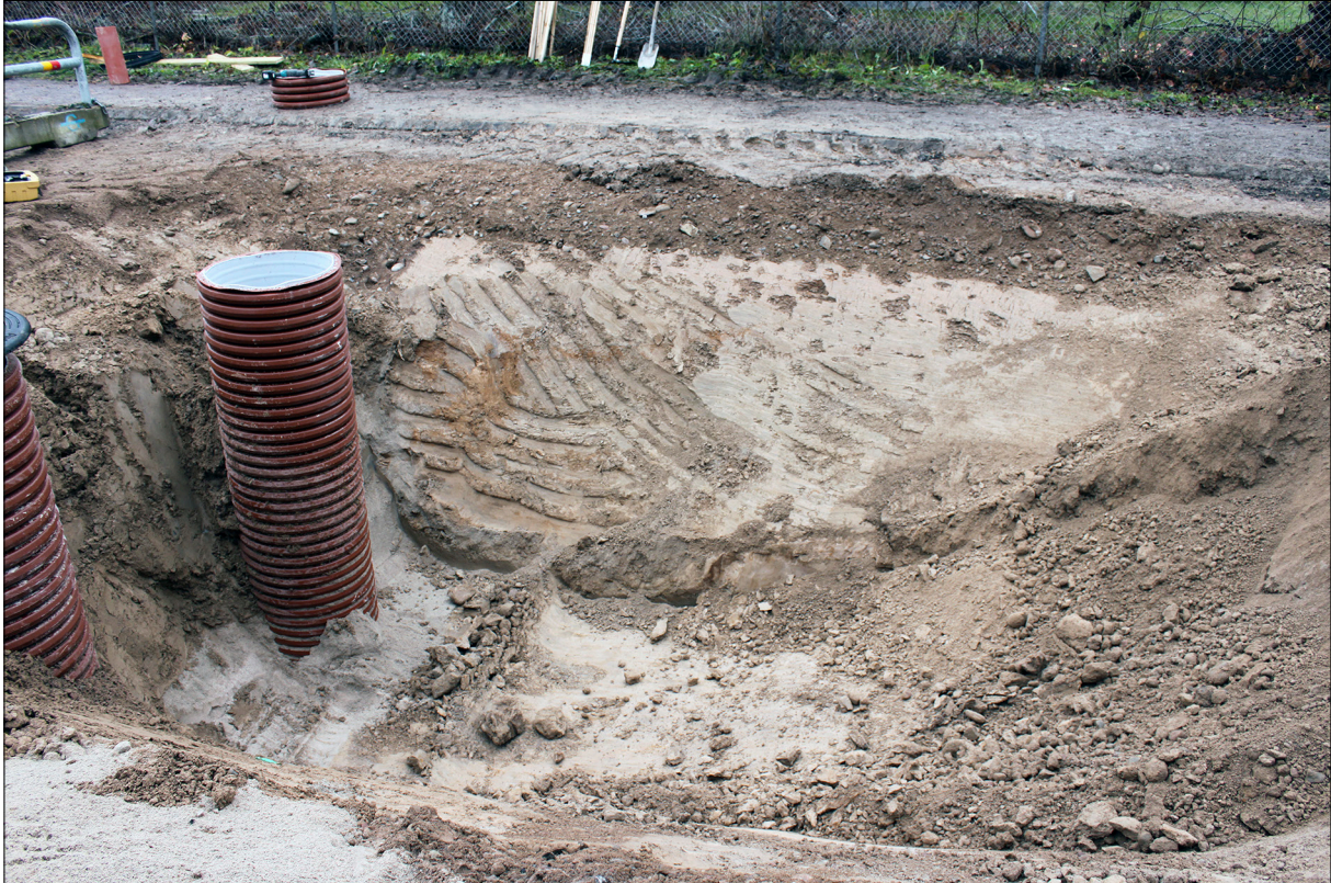
Figur 4. Schaktprofil som visar befintlig asfaltsväg vilande på ett stenigt bärlager. Direkt under bärlagret framkom antingen undergrunden eller anläggningar/kulturlager. Undergrunden utgjordes av skiktad gul lera. Foto från sydväst.
