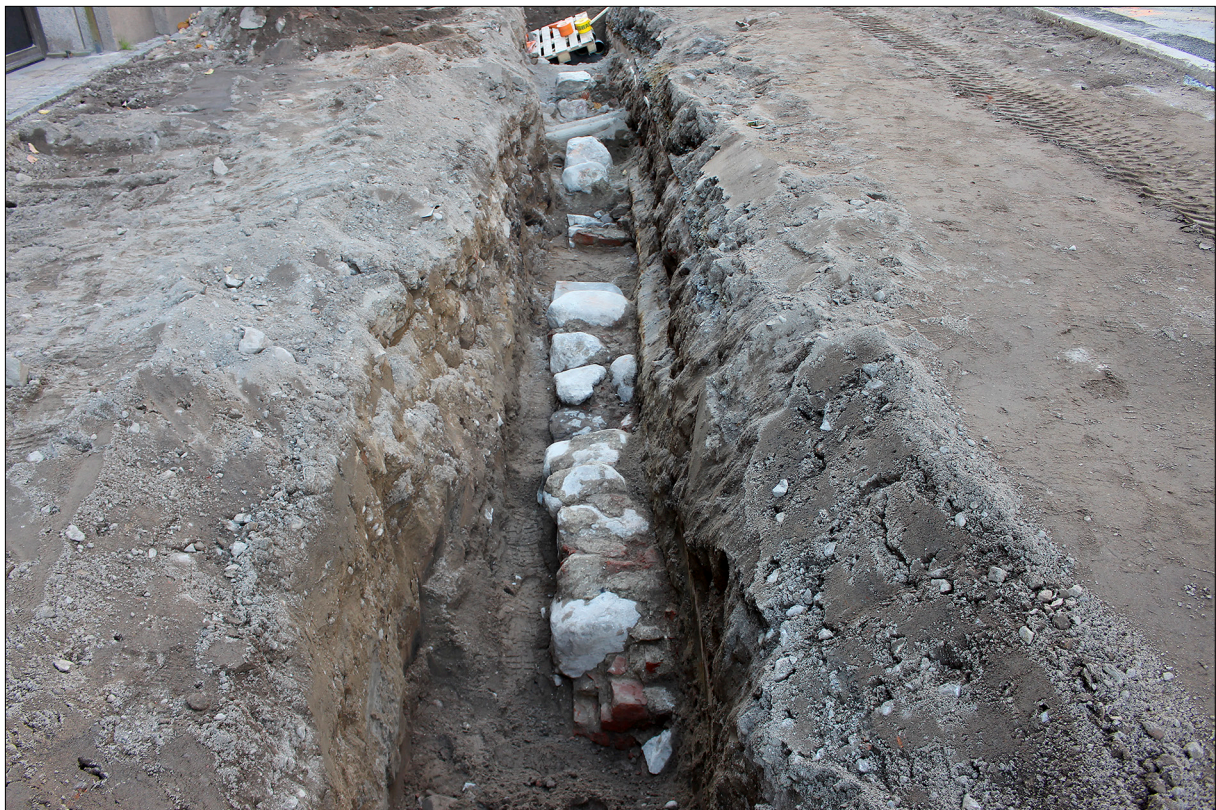
Figur 11. En översikt av den västra delen av grundmuren intill Operan. Foto från nordost.
