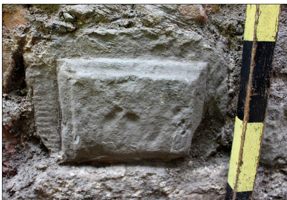
Figur 13. En kvadersten inmurad i mur 512 i den östra delen av grundmuren. Foto från sydost.
