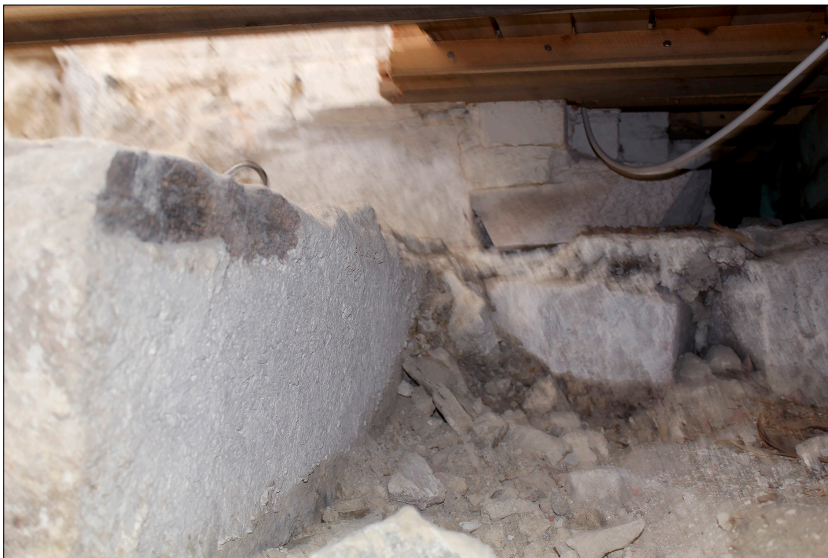
Figur 12. En av stenarna i södra långhusväggen var vitmålad på insidan. Foto från öster.
