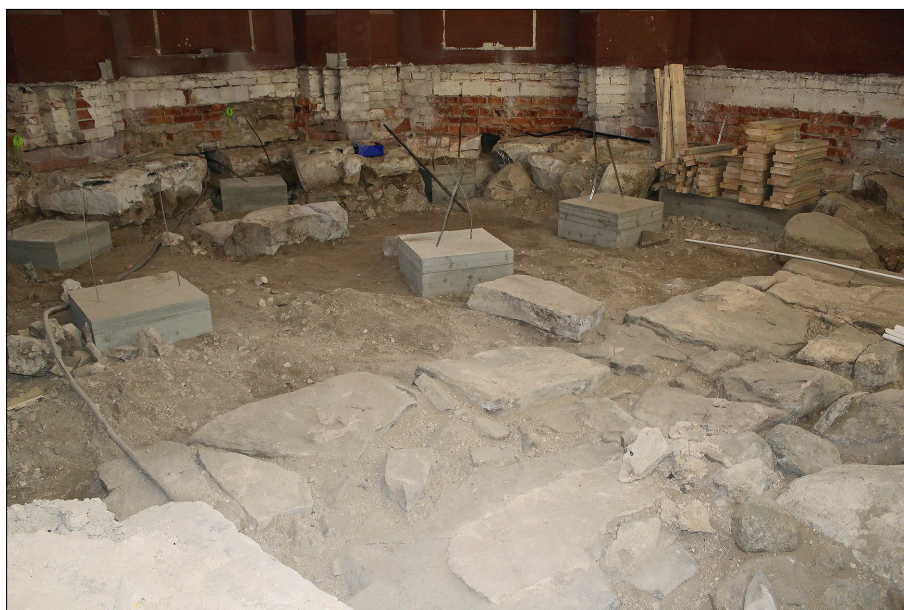
Figur 7. Golvet i koret hade avlägsnats och delar av sandfyllningen hade tagits bort med sugbil. Foto från nordväst.
