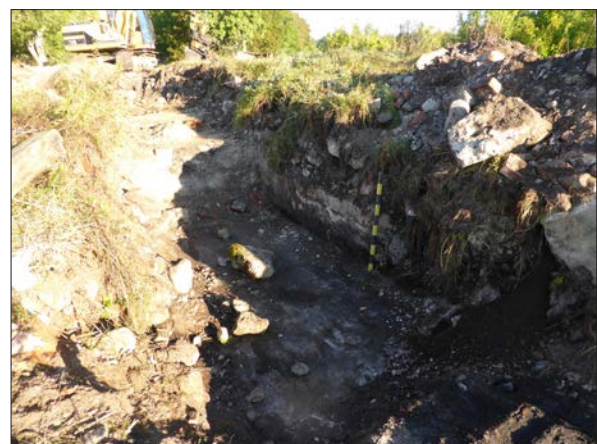
Figur 16. Schakt genom källaren i östra delen av senaste boningshuset. Foto från Ö.
