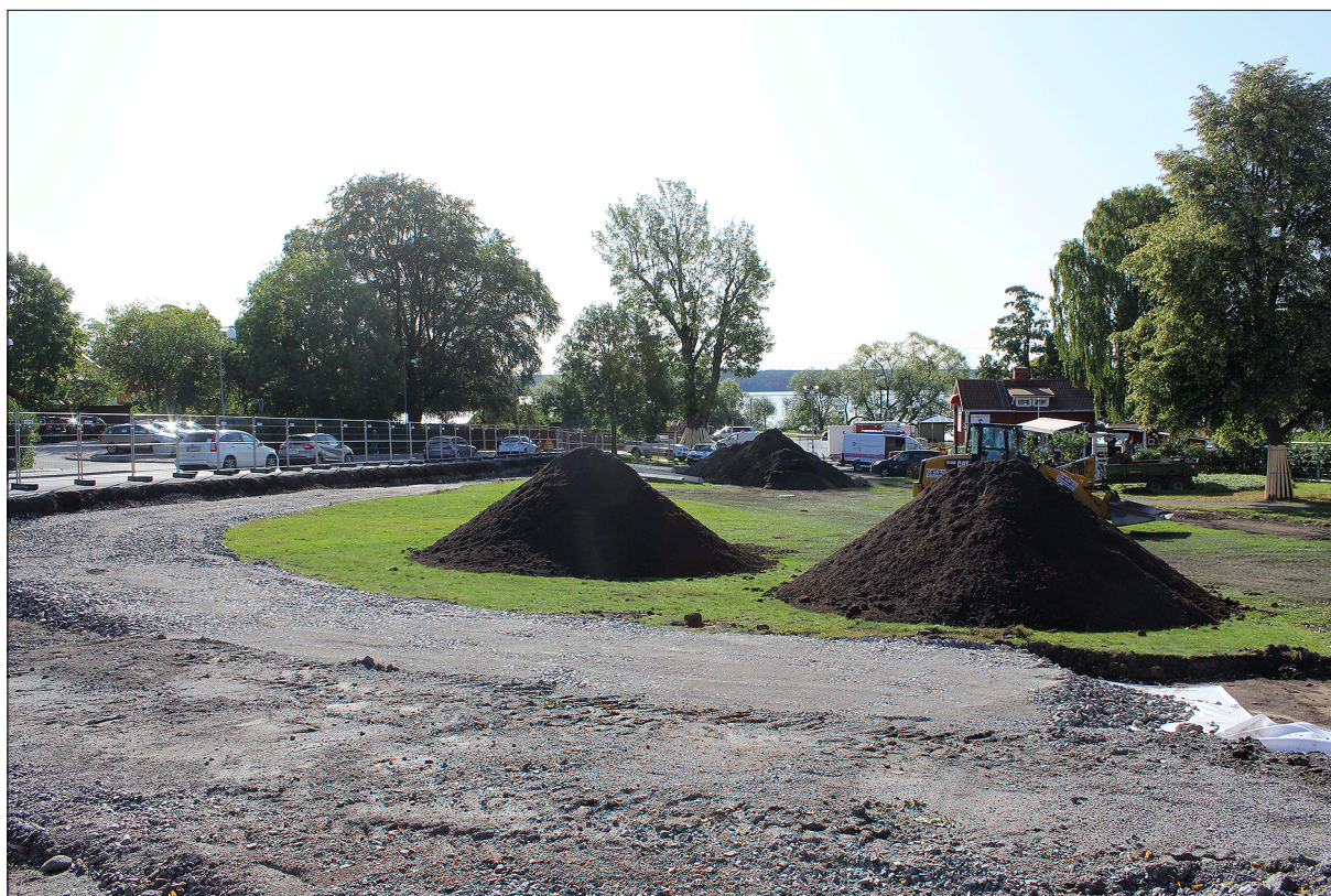
Figur 4. Arbetsvägen som anlades runt Borgmästarängen, vars utbredning också kom att mätas in om schakt 1. Foto från norr.
