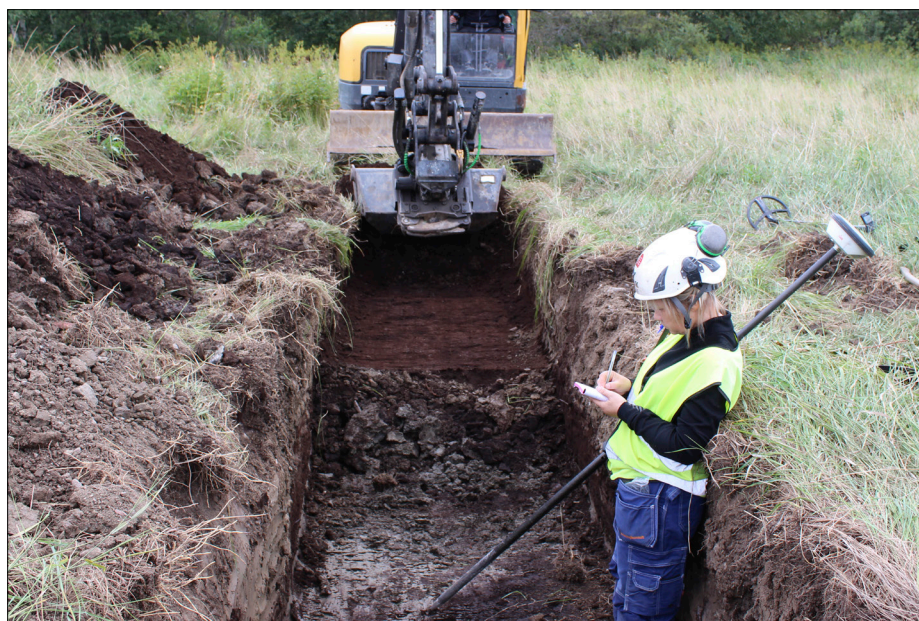
Figur 9. Sökschaktning i den västra delen av undersökningsområdet. Längst bort i schaktet syns rödbrun torv från den utdikade mossen. Närmast i bild var marken störd, med rikligt med påförda massor. Foto från väst.
