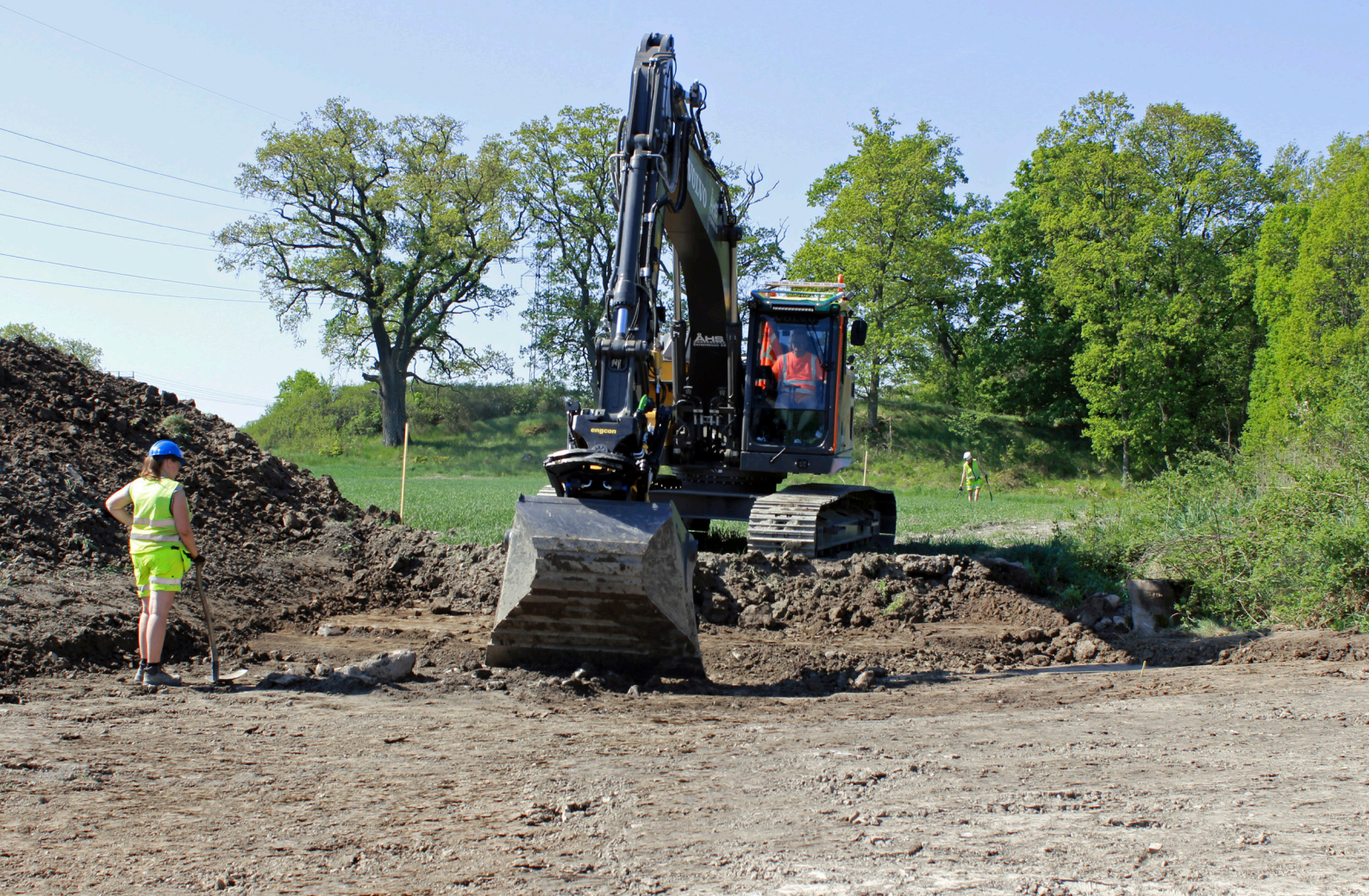
Figur 12. Matjordsavbaning i den nordöstra delen av undersökningsområdet. I bakgrunden pågår metalldetektering av ploglagret. Foto från nordöst.
