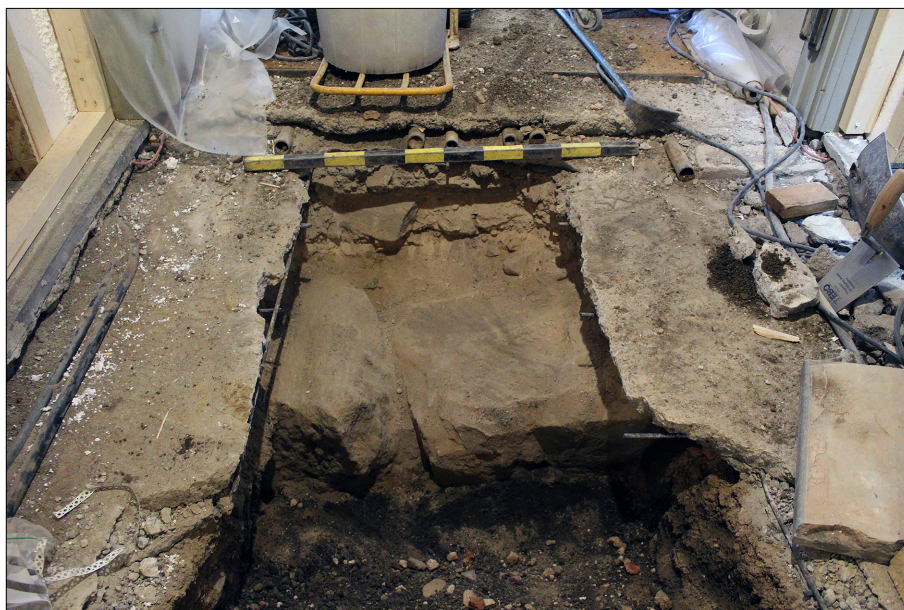
Figur 6. Gropen innanför långhusets port med kyrkmurens grundstenar synliga. Foto från öster.
