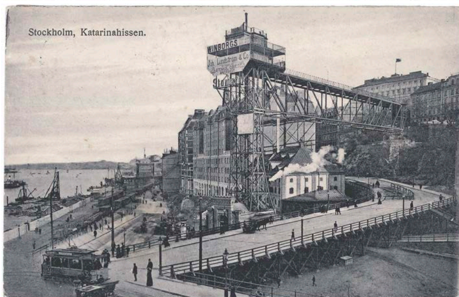
Figur 78. Vykort visande miljön kring undersökningsområdet före och efter rivningarna av kvarteren Ormen och Glasbruket Större. Det övre kortet är poststämplat 1901 och där ses den brant stigande Stora Glasbruksgatan och Ormen 18–19 som är byggnaden med en mörkare fasad under Katarinahissens gångbro. På det undre vykortet, som är poststämplat 1932, är Katarinavägen framdragen och all bebyggelse i kvarteren Ormen och Glasbruket Större utmed vägens sträckning är jämnad med marken och endast kalt berg är synligt.
