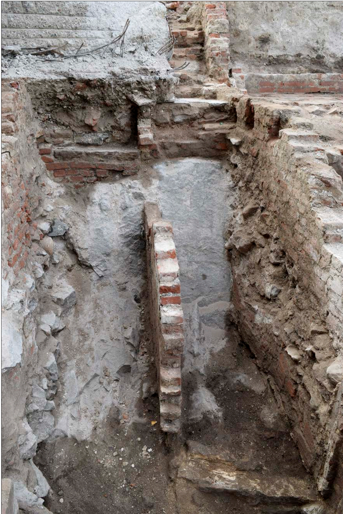
Figur 25. På bilden ses källarrummen 26–27 i Ormen 19. Liksom i flera av de andra källarrummen var golvytan minimerad på grund av berget som upptog en stor del av utrymmet. Dessa källare var dessutom mycket små och hade en bredd av 0,8 respektive 1 m. Foto från norr.
