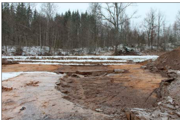
Figur 20. Vägkonstruktion 735 på väg att schaktas bort. I bakgrunden syns ett litet öppet stråk som är färdväg L2008:8993. Foto från söder.
