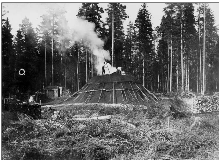
Figur 10. De t-formade stöden, så kallade balkro, håller stybben på plats på resmilans utsida. Bjurfors, Västmanland 1908. Foto. SLU:s externa mediabank, bildid 13647.
