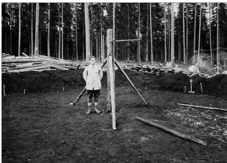
Figur 9. Platsen där resmilan ska anläggas är iordninggjord och den så kallade bordstaken/kungen är satt på plats. Foto. SLU:s externa mediabank, bildid 13637.
