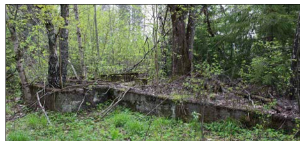
Figur 10. Husgrund (101) med syll i betong. Foto från nordväst.
