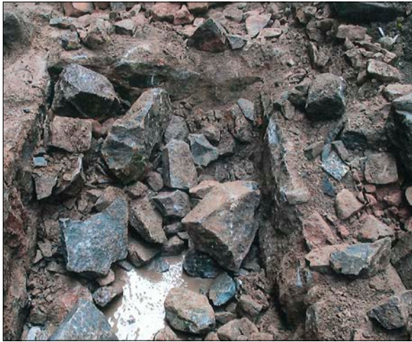
Figur 6. Tömning av stenfyllningen (106) med grundmur 102 till vänster i bild, grundmur 103 överst i bild och stenfundament 108 till höger i bild. Foto från nordost.
