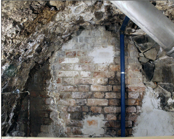
Figur 13. Den inre vallgravsmurens insida, den sida som vetter mot slottet. Bilden visar den översta delen av muren så som den är synlig i källarrum 606. Foto från nordöst.
