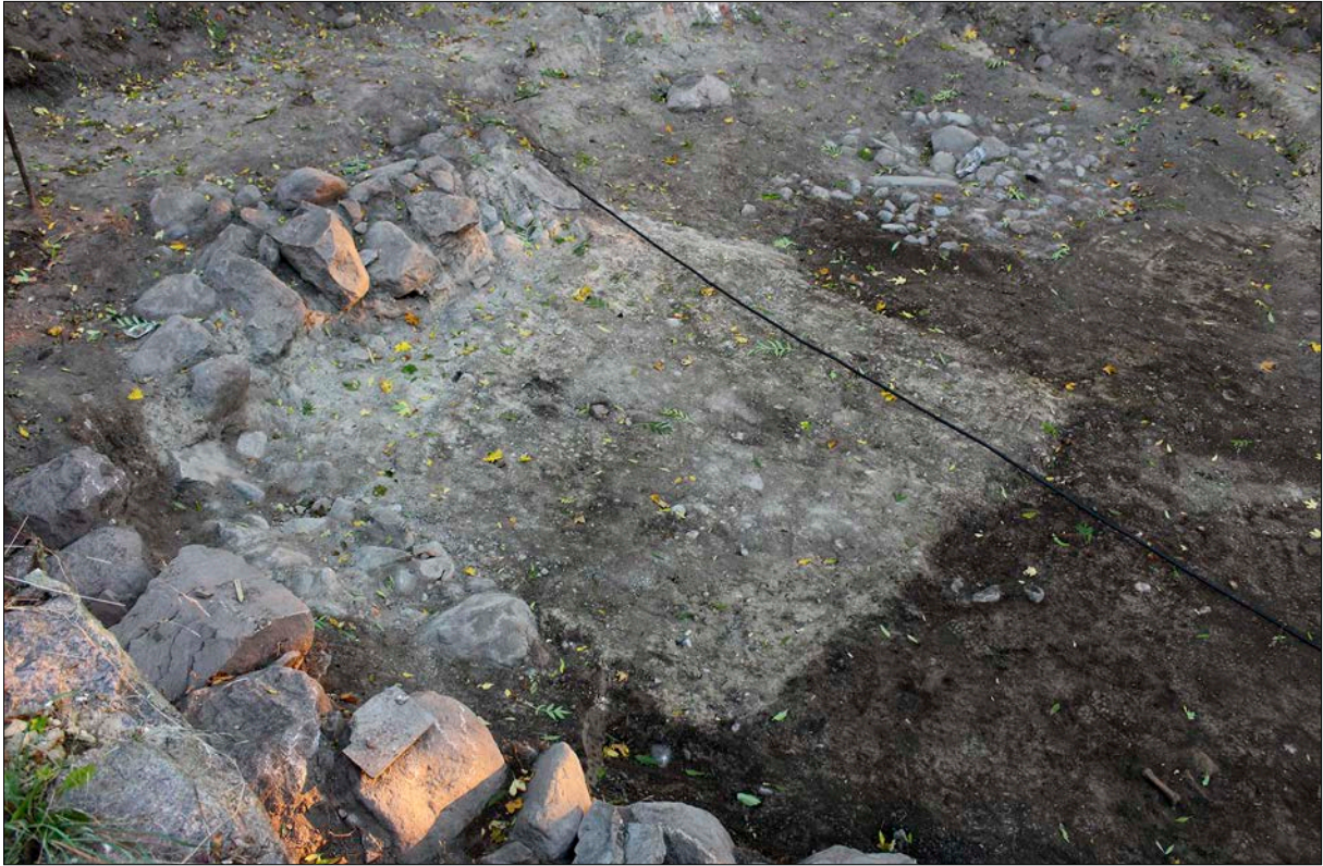
Figur 23. Stensyllskonstruktion i område 2. Innanför syllstensraderna (5 och 21) påträffades en ljus fyrkant som representerar det yngsta återfyllnadslagret i en större nedgrävning (24). Nedgrävningen har sannolikt fungerat som källare till byggnaden. Foto från sydväst.
