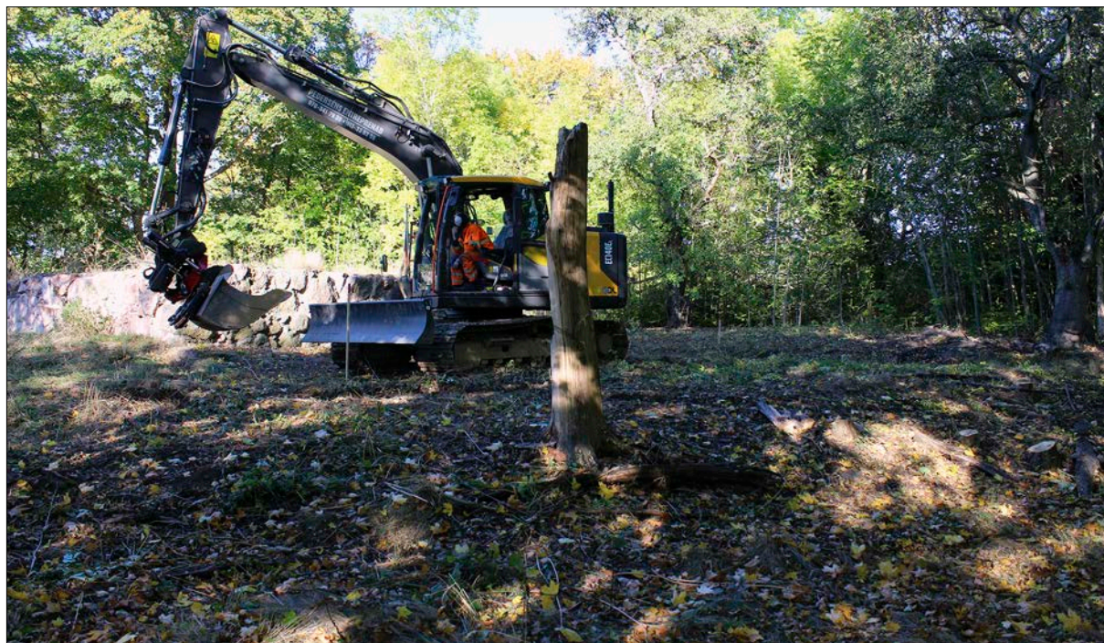
Figur 21. Översikt bild över område 2 innan schaktning. I bakgrunden syns delar av den yngre stenkällargrunden till spannmålmagasinet som delvis sträckte sig in i område 2. Foto från söder.
