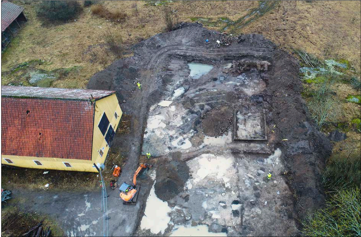
Figur 35. Översiktbild över syllstenskonstruktion 199 och 165. Den södra delen av konstruktionen 129 är vid tiden för fotot borttagen. På bilden syns även den inre moderna betongsyllskonstruktionen. Spridningstillstånd från Lantmäteriet med ärendenummer LM2019/009978.
