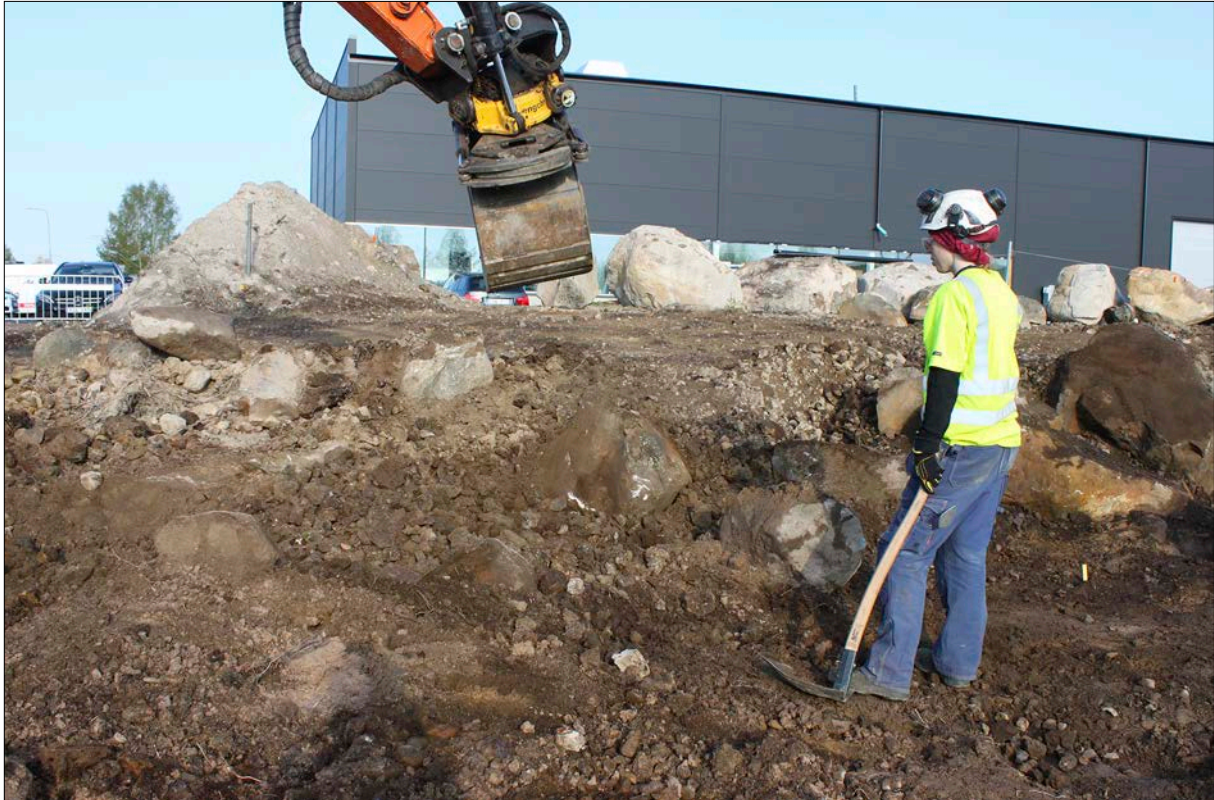
Figur 12. De tunga och svårhanterliga slagglagren schaktades till största del med maskin, men en stor del handgrävdes även, efter bästa förmåga och med lite maskinunderstöd. Foto från sydost.
