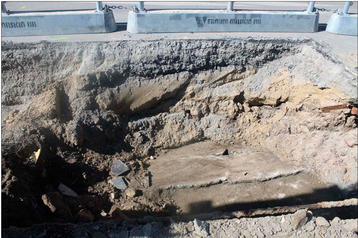
Figur 11. Betongfundament (4) under stengrund (3) och tegelkross lager (5). Foto från söder.
