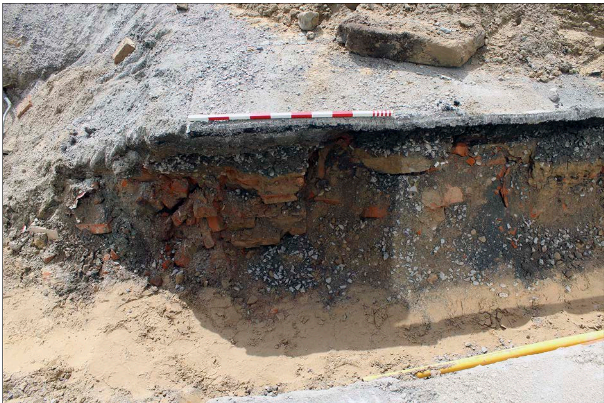
Figur 12. Lager med tegelkross (5) i sektionvägg, resterande delen av schaktet var sedan tidigare urschaktat och ifyllt med sand vid äldre ledningsgrävningar. Foto från norr.
